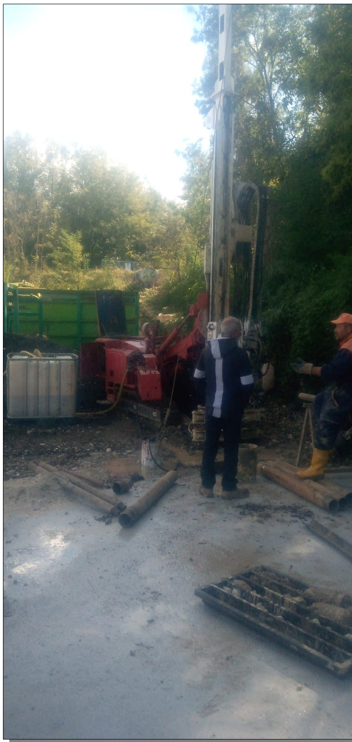
Perforazione del sondaggio S2 con installazione del piezometro Pz 2.
