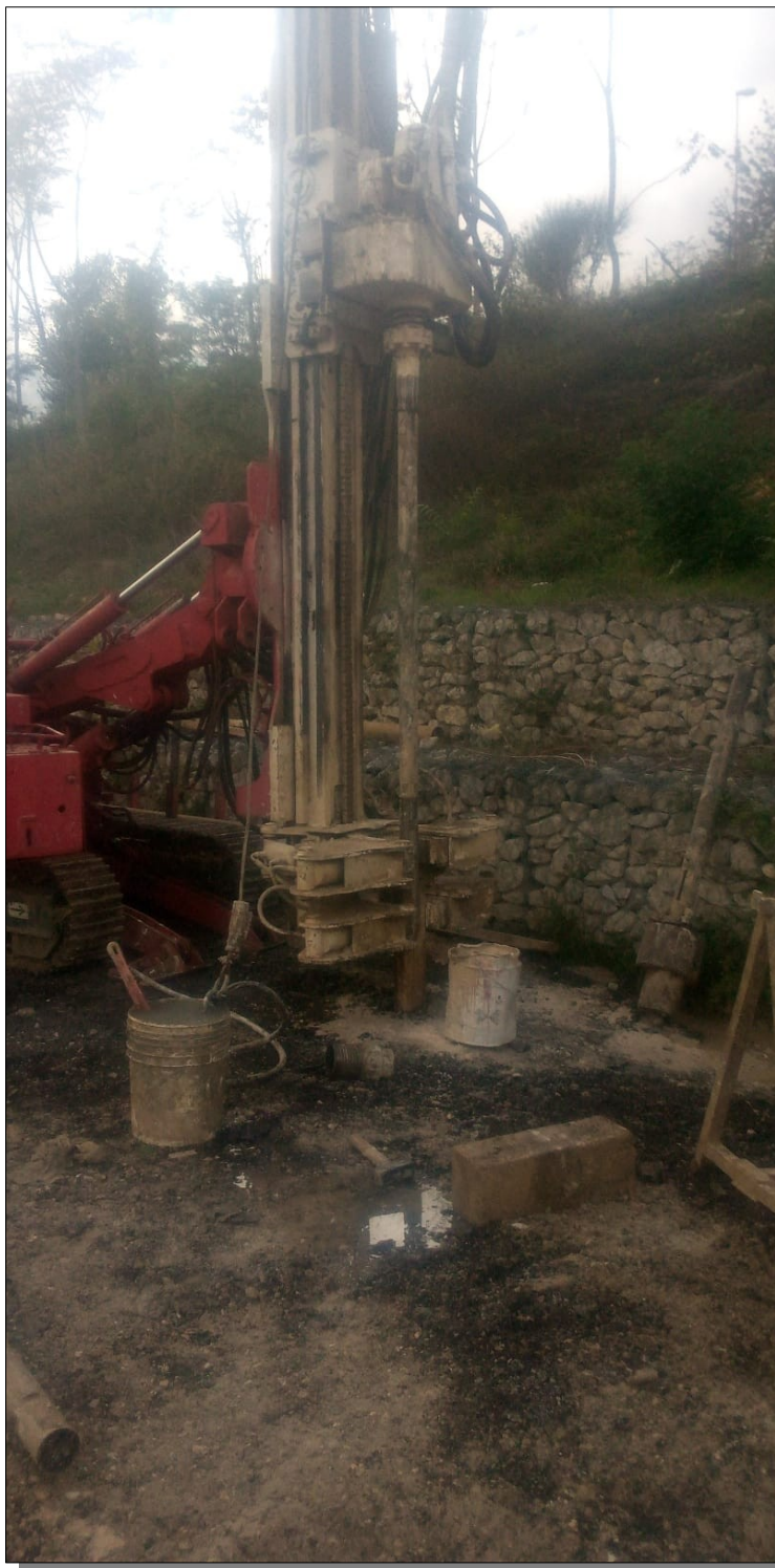
Perforazione del sondaggio S3 con installazione del piezometro Pz 3.
