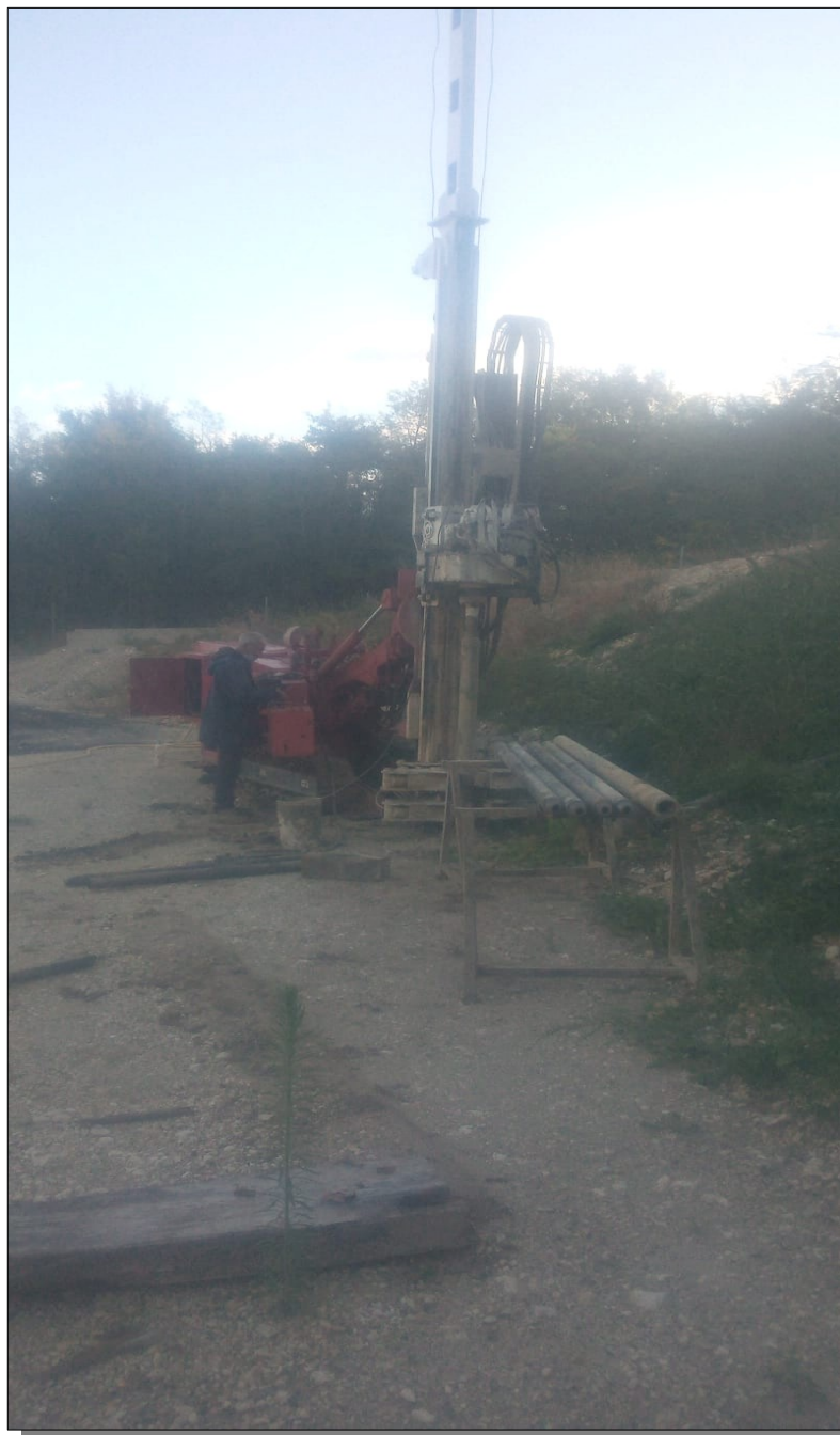
Perforazione del sondaggio S1 con installazione del piezometro Pz 1.
