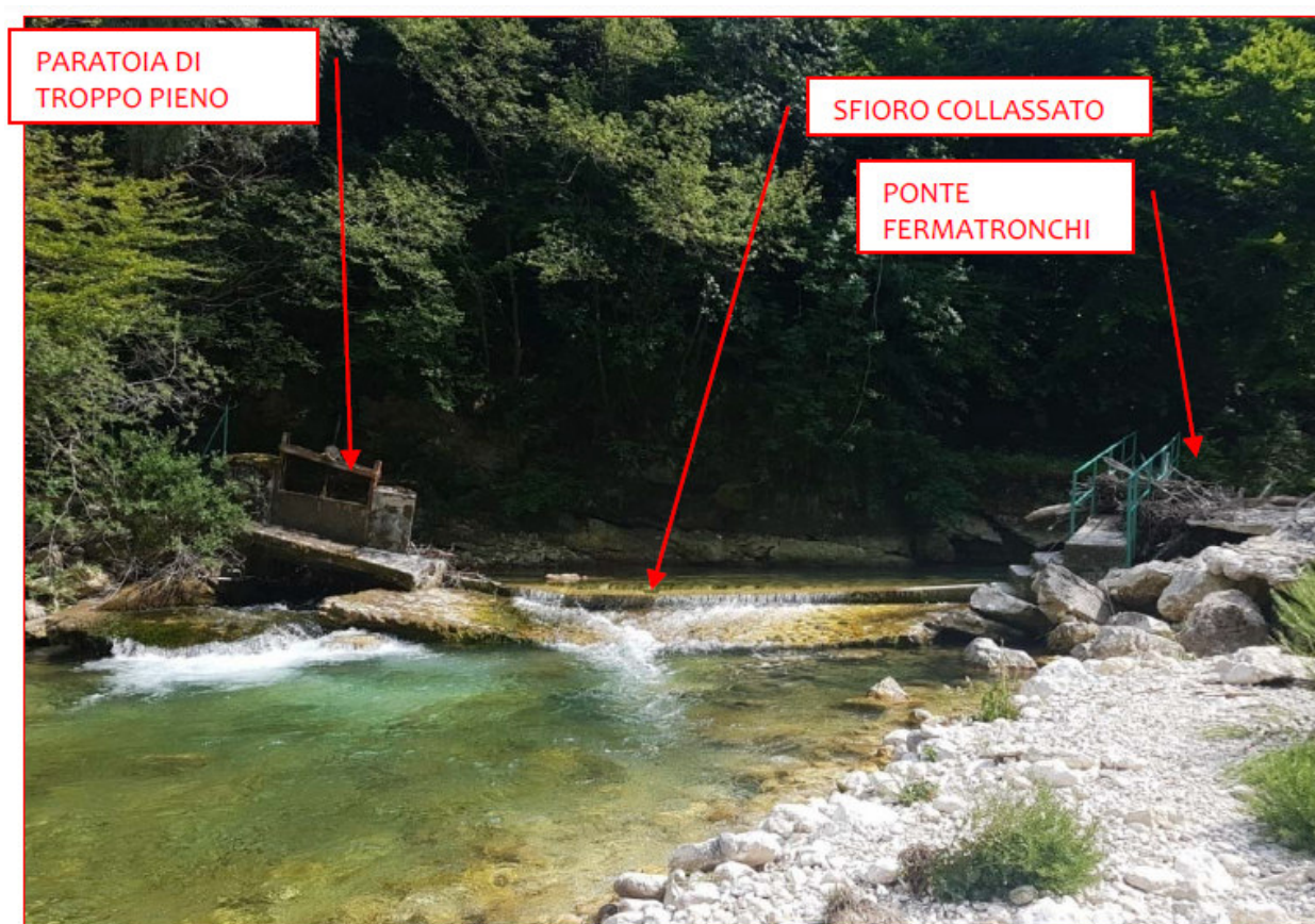
Figura 3 - Sfioro collassato in corrispondenza dell'opera di presa prima dell'alluvione del Novembre 2018
