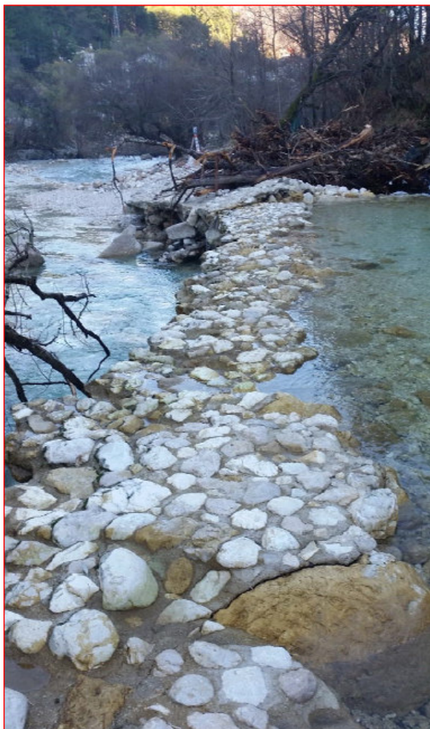
Figura 1 - Opera di presa – pennello- dopo alluvione del novembre 2018
