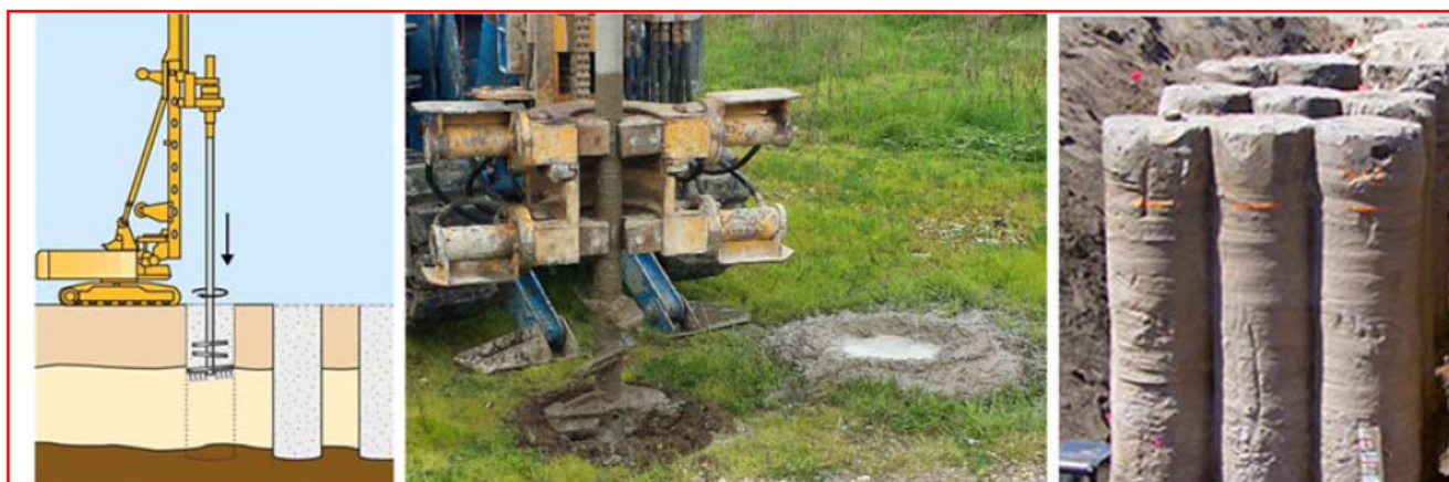
Figura 15 - Deep soil mixing: schema esecutivo, macchinario per esecuzione trattamenti, colonne tangenti esposte.
