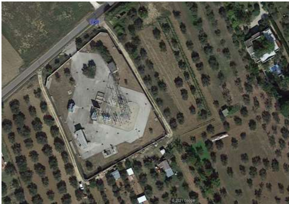
Figura 2: Immagine aerea cabina primaria AT/MT ROSCIANO
