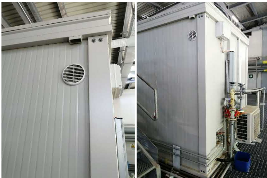
Figura 1: Dettaglio del punto di emissione dell'unità di ricambio aria del laboratorio per il monitoraggio in continuo della salamoia (impianto clorito di sodio)
