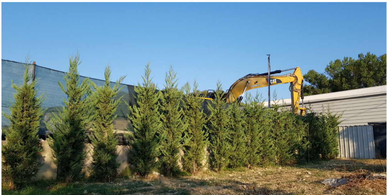
Fig.2 - Barriera frangivento Lato Nord- Est – Doppia barriera frangivento (Foto scattata dall'esterno dell'impianto)
