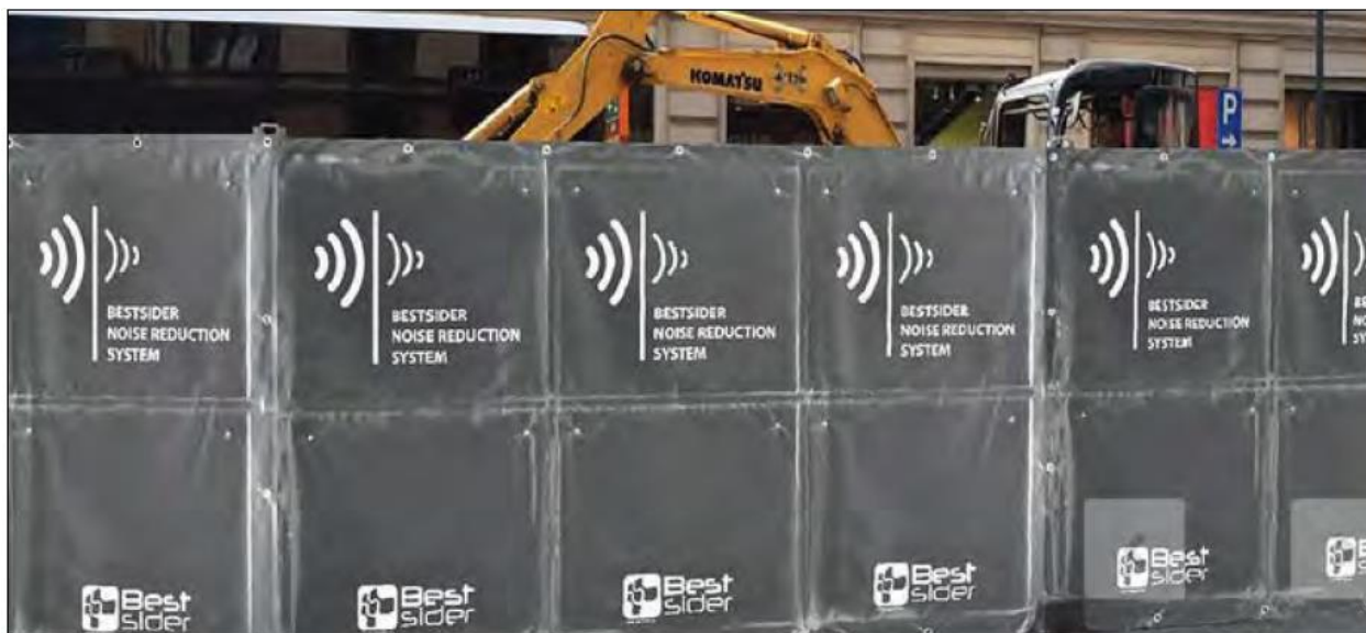
esempio di pannello di abbattimento rumore in fase di cantiere
