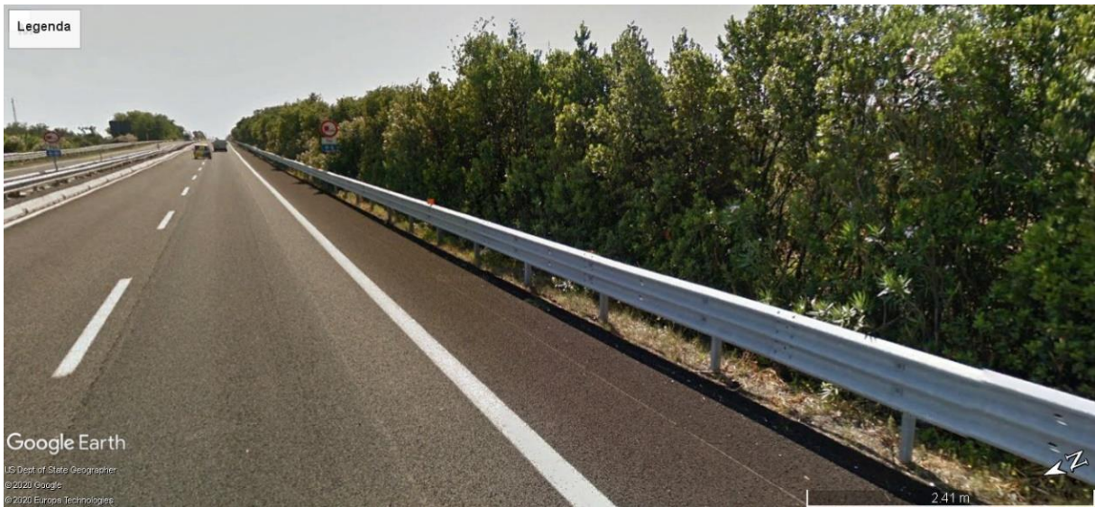
Corsia autostrada - foto street view
