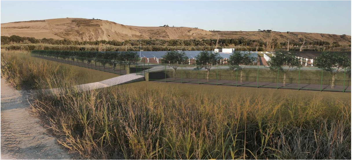
Vista della sezione Sud dell'impianto FV
