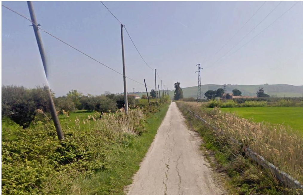
Strada Comunale Padula, in prossimità delle aree di produzione, sulla quale passerà il cavidotto interrato
