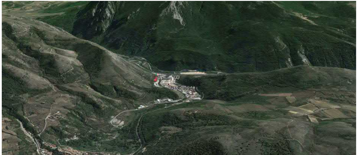
Figura 32: Vista Est – Ovest dello stabilimento di Bussi.
