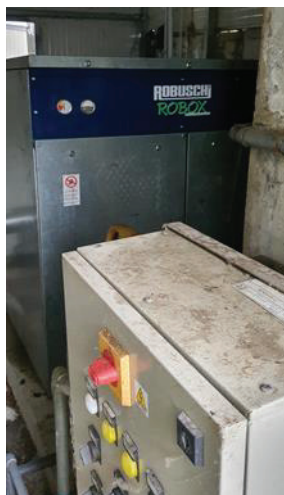
7-5 – Locali confinati per elettromeccaniche a ridotta emissione acustica
