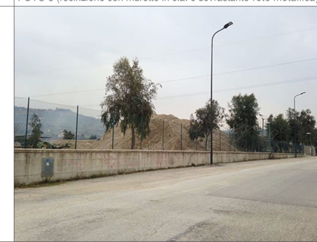
FOTO 5 (recinzione con muretto in c.a. e sovrastante rete metallica)
