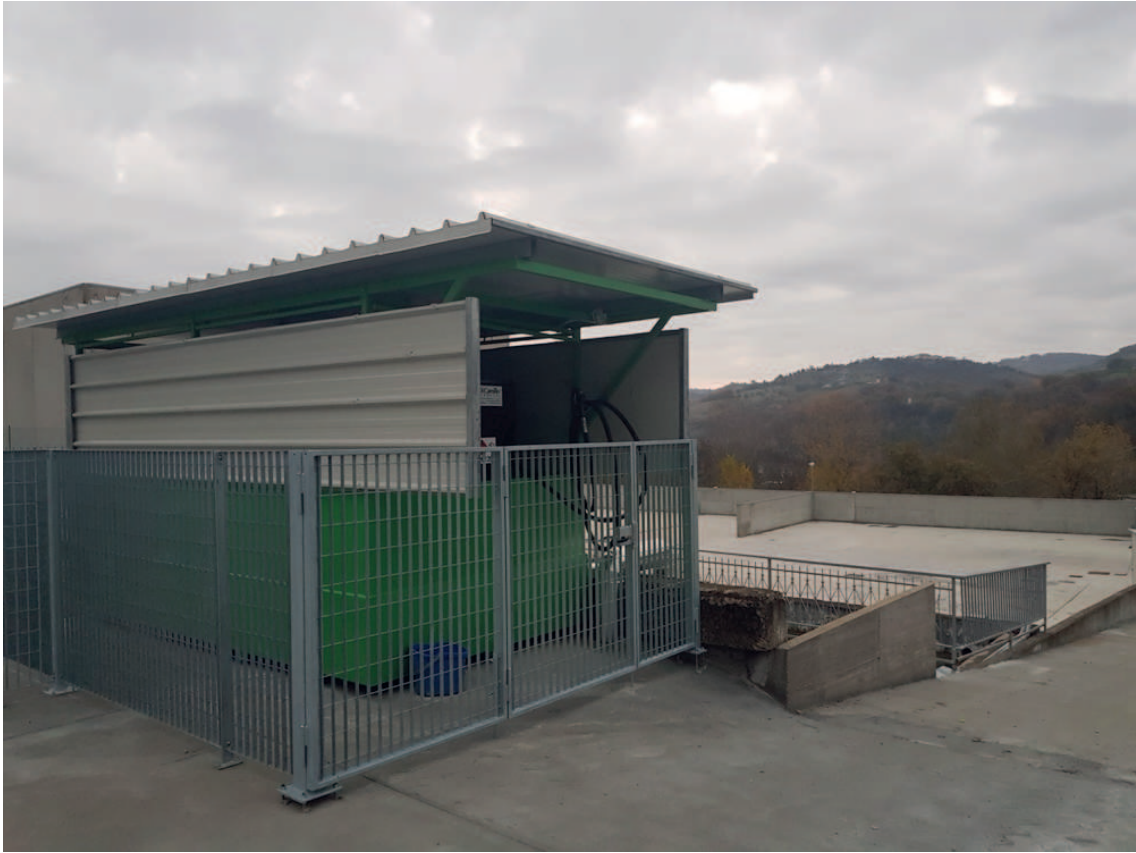
Fig. 41. Serbatoio gasolio
