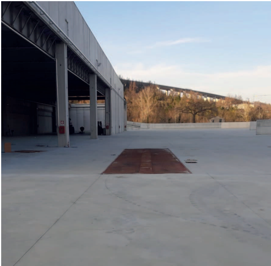
Fig. 40. Pesa a ponte
