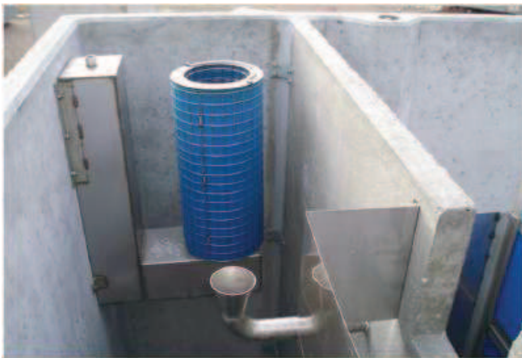
Particolare otturatore meccanico con relativo filtro a coalescenza.
