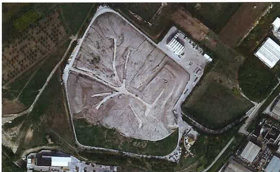
Figura 1 - Vista aerea della discarica
