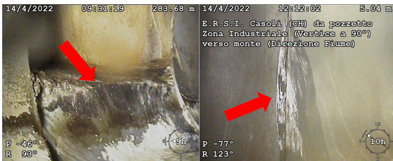
Figura 4-3 – Infiltrazioni da videoispezione nel collettore fognario a monte dell'impianto depurazione di Casoli
