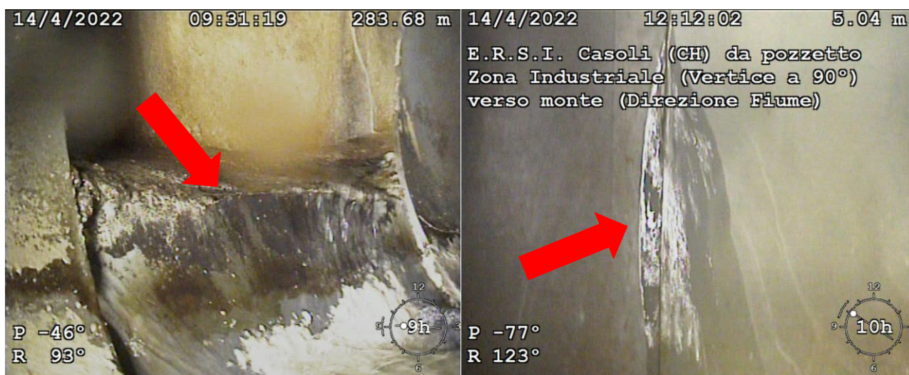
Figura 3-2 – Infiltrazioni da videoispezione nel collettore fognario a monte dell'impianto depurazione di Casoli
