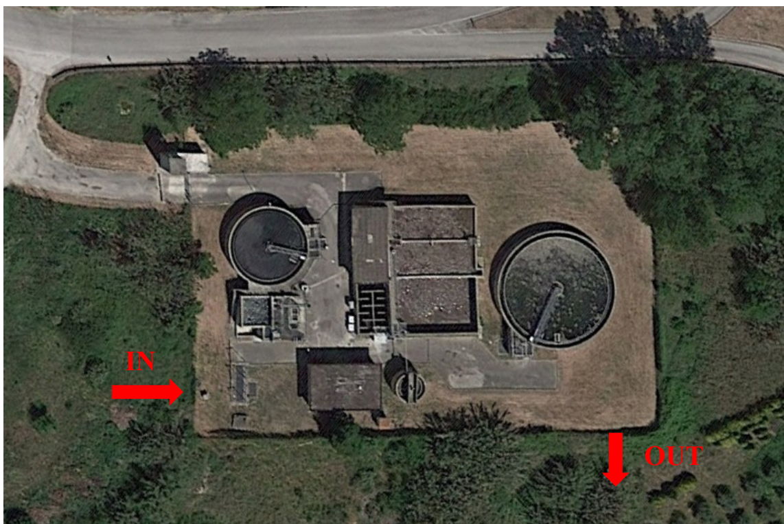
Figura 5-2 - Area del depuratore
