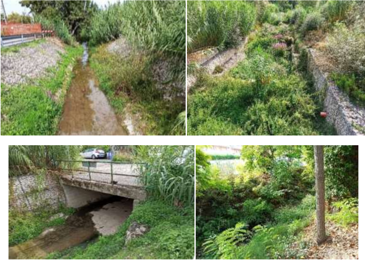
Figura 3.5 - Rilevo fotografico del settembre 2021 in cui si può vedere l'alveo nei pressi dell'attraversamento di Francia (in alto) e dell'imbocco del tratto tombato (in basso)
