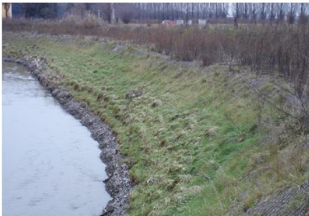
Aspetto delle pareti del canale a inerbimento completato (1 annoi dalla posa)
