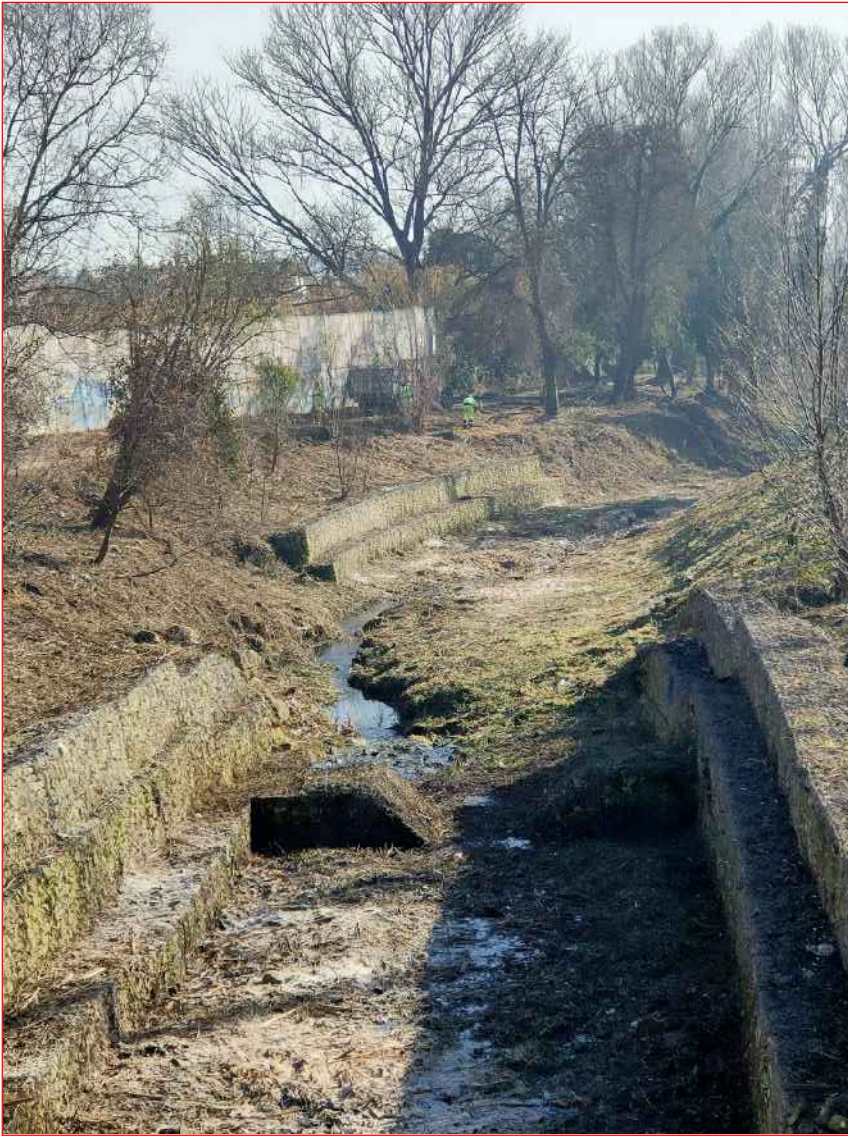
foto 4 - briglia con sponda in franamento rilievo dopo manutenzione maggio 2021
