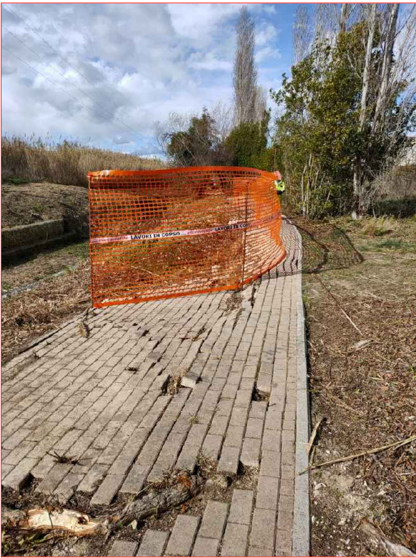
foto 6 - sponda in franamento rilievo maggio 2021
