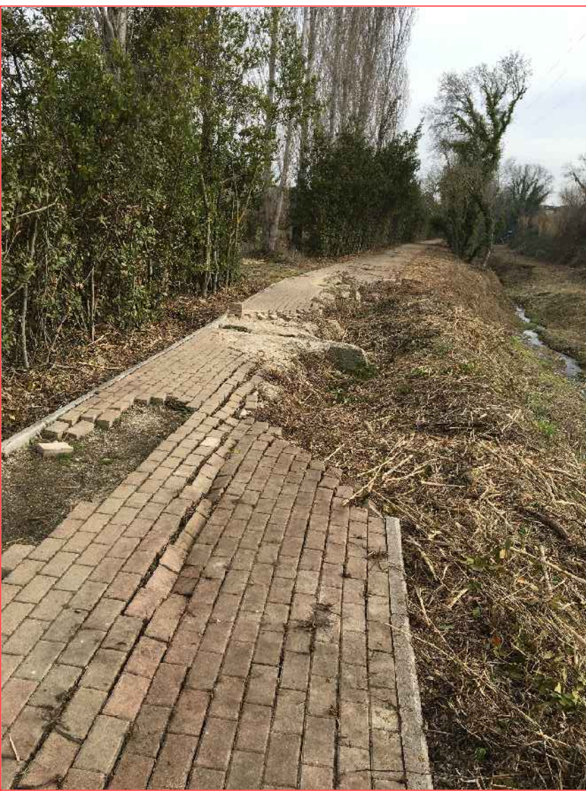
foto 5 - sponda in franamento rilievo dopo manutenzione maggio 2021
