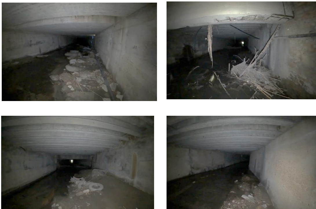
Figura 4-2: Video ispezione del tratto tombato: in alto si possono notare tratti del tombino dove si trovano accumuli di materiale, in basso a sinistra un abbassamento del cielo e in basso a destra un restringimento della sezione
