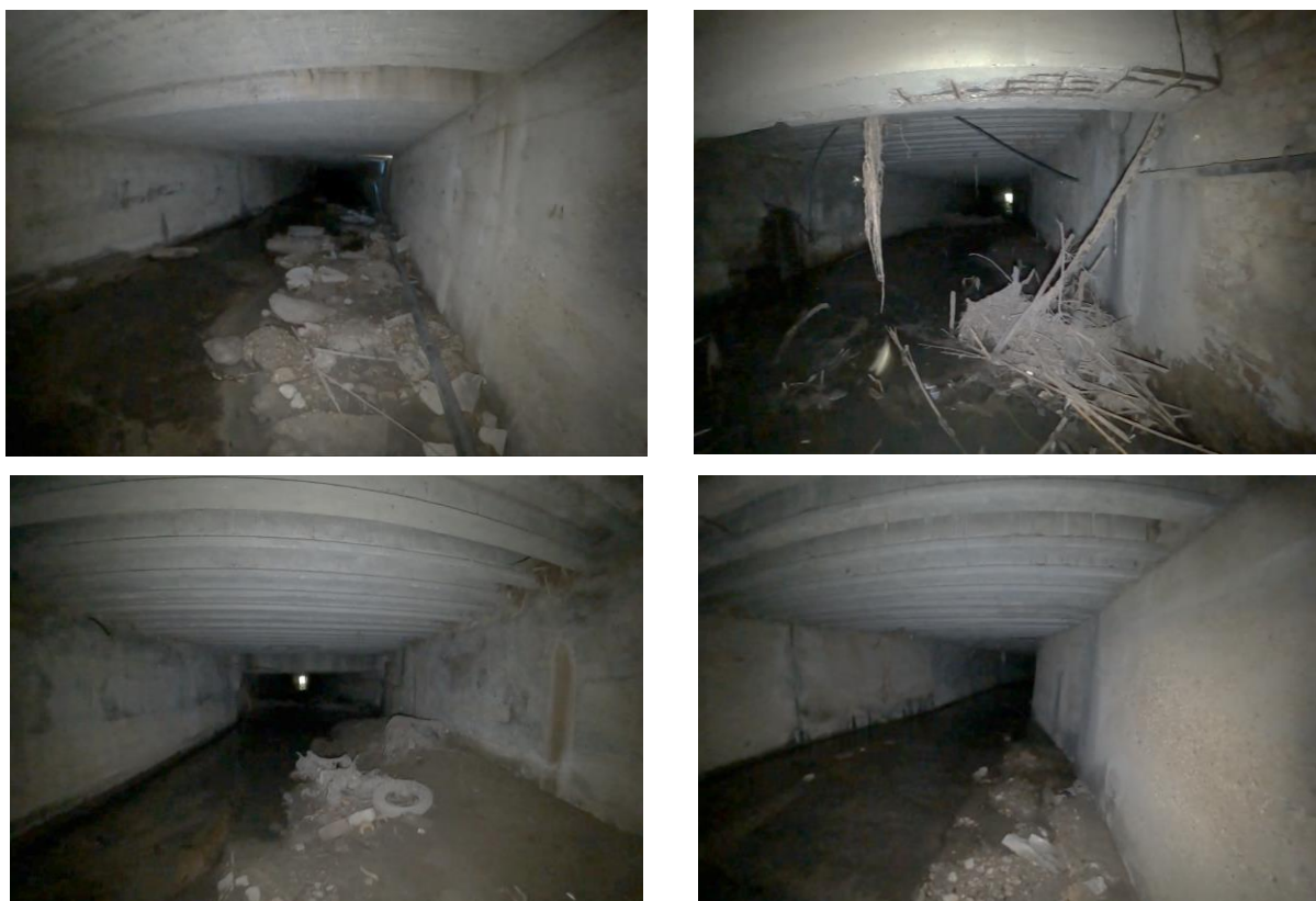
Figura 2-3: Video ispezione tratto tombato: in alto si possono notare tratti del tombino dove si trovano accumuli di materiale, in basso a sinistra un abbassamento del cielo e in basso a destra un restringimento della sezione
