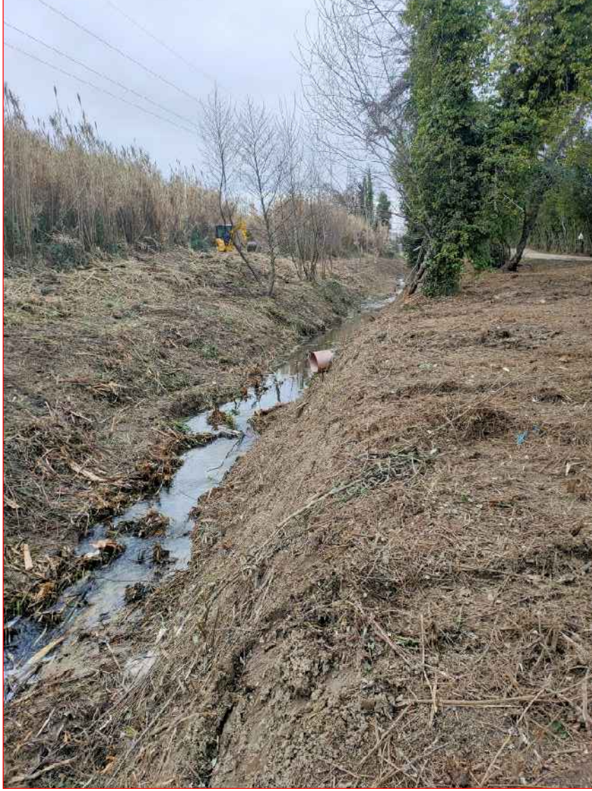
foto 3 - sponde del canale instabili rilievo dopo manutenzione maggio 2021
