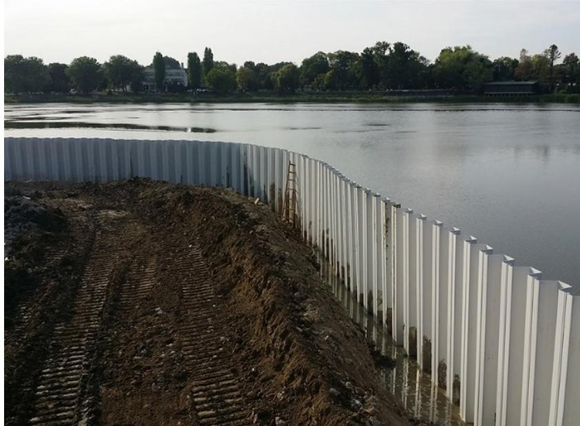
3-5 - Esempio di palancolata con funzione idraulica
