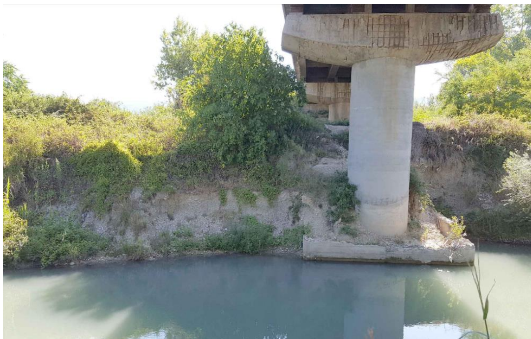
Figura 5-3 Erosione in destra idraulica ed esposizione della sovrastruttura della pila n.4 del viadotto Pescara 2
