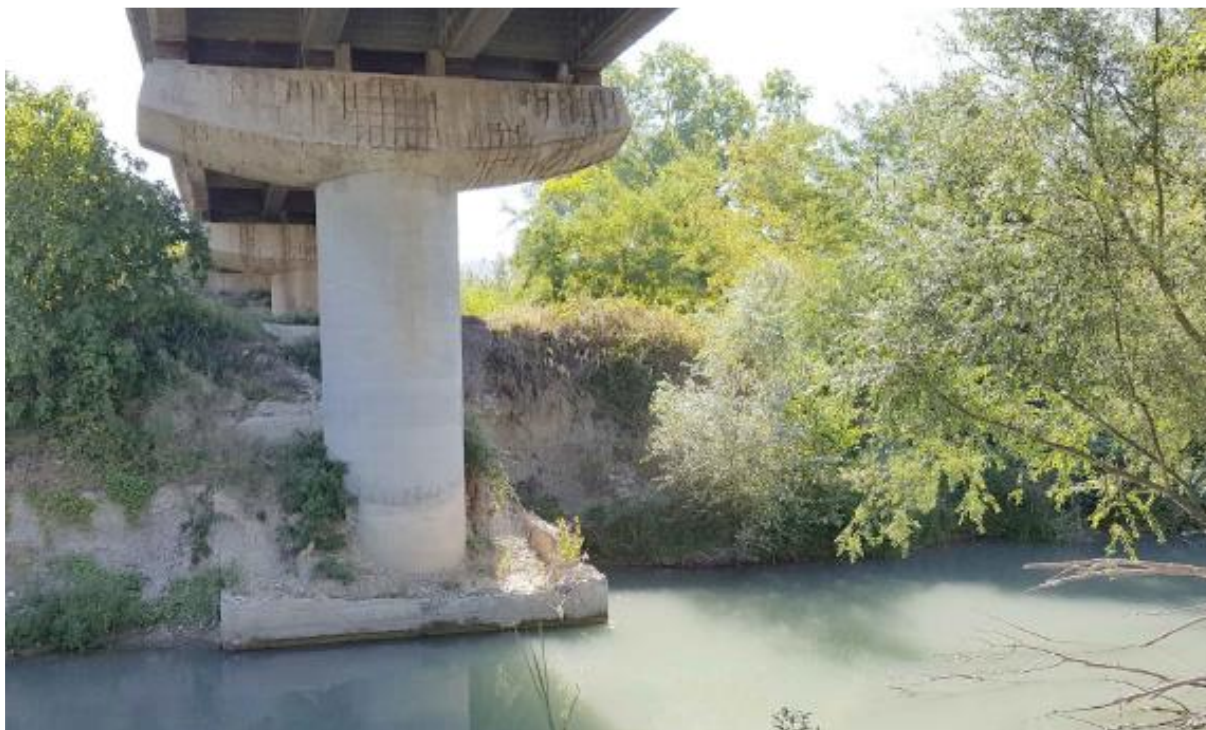
Figura 7-38 - Erosione in destra idraulica ed esposizione della sovrastruttura sul plinto della pila 4
