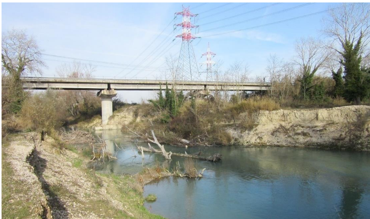
Figura 7-37 - Vista di monte del viadotto con gli evidenti segni di erosione in destra e sinistra
