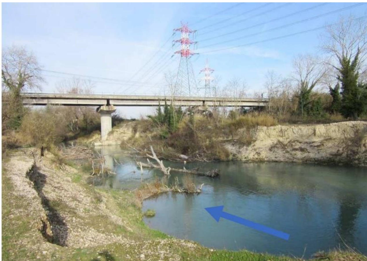
Figura 5-2 Vista di monte del viadotto con evidenti segni di erosione delle sponde in destra e sinistra e pila n.4 del viadotto Pescara 2 sullo sfondo
