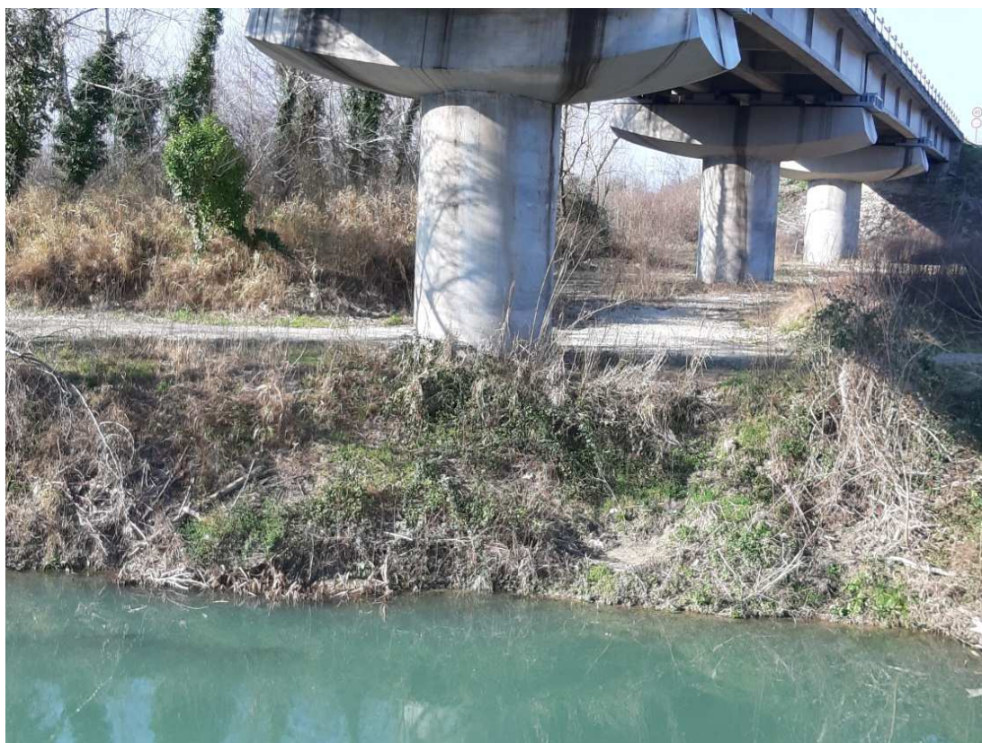
Figura 10 – “Erosione in sinistra idraulica (Pila 3)”
