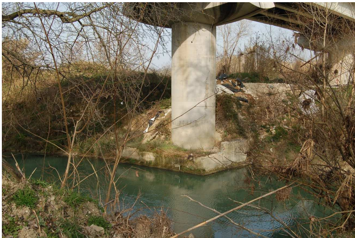
Figura 11 – “Erosione in destra idraulica ed esposizione della sovrastruttura in CLS affiorante sul plinto della pila 4”
