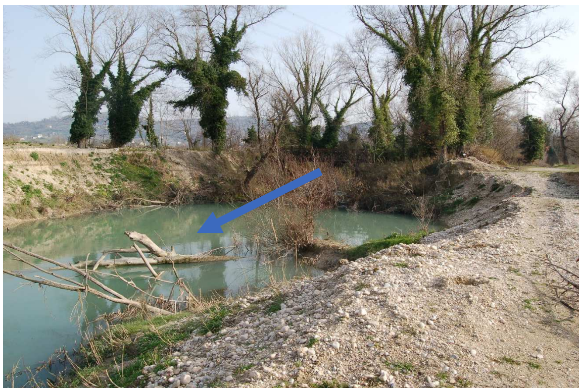
Figura 12 – “Zona a monte del viadotto nella quale sono avvenuti i franamenti delle sponde”
