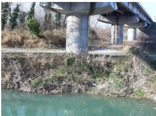
Figura 10 – “Erosione in sinistra idraulica (Pila 3)”
