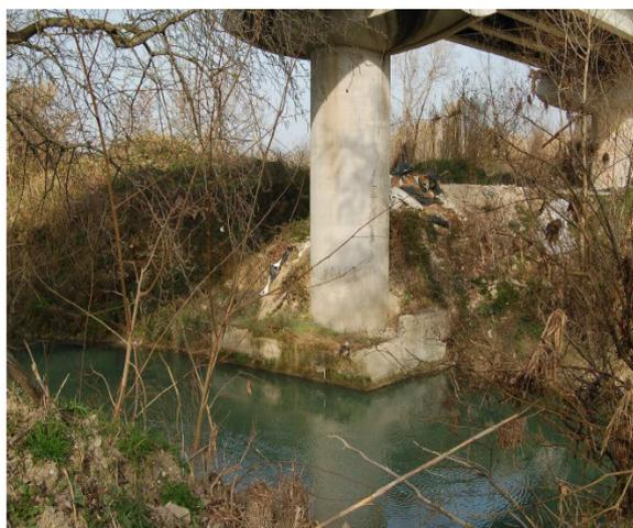
Figura 11 – “Erosione in destra idraulica ed esposizione della sovrastruttura in CLS affiorante sul plinto della pila 4”
