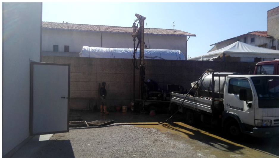
Fig.2 – Postazione di sondaggio
