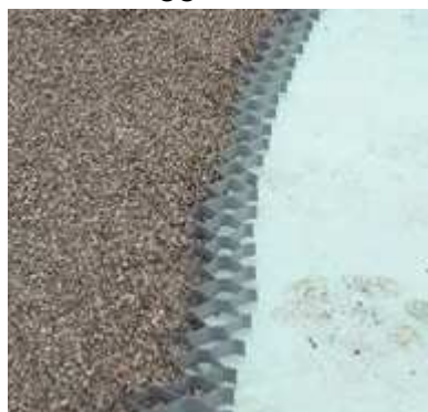
Geocella riempita con misto e geotessile
