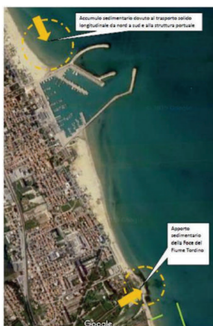
Veduta aerea per l’analisi dei potenziali impatti che potrebbe indurre la trasformazione dell’esistente area portuale secondo le nuove ipotesi progettuali
