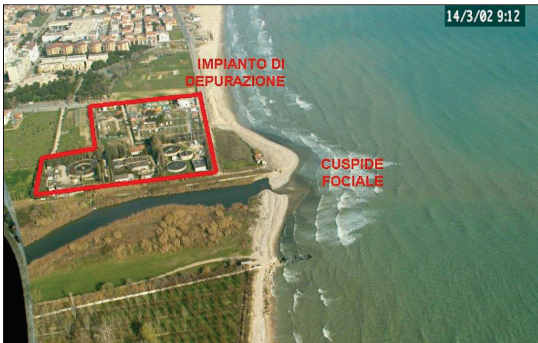
Figura 34 - Foto aerea della foce del Torrente Tordino (volo marzo 2002)
