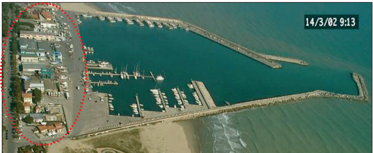
Figura 5 - Vista aerea del Porto da cui si evidenziano le strutture di servizio dislocate sul fronte interno del porto.
