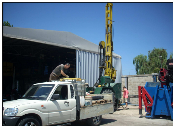
Realizzazione del sondaggio PZ1 (a sinistra) e PZ2 (a destra) per l'installazione dei piezometri
