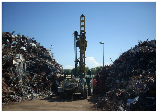
Realizzazione del sondaggio PZ1 (a sinistra) e PZ2 (a destra) per l'installazione dei piezometri
