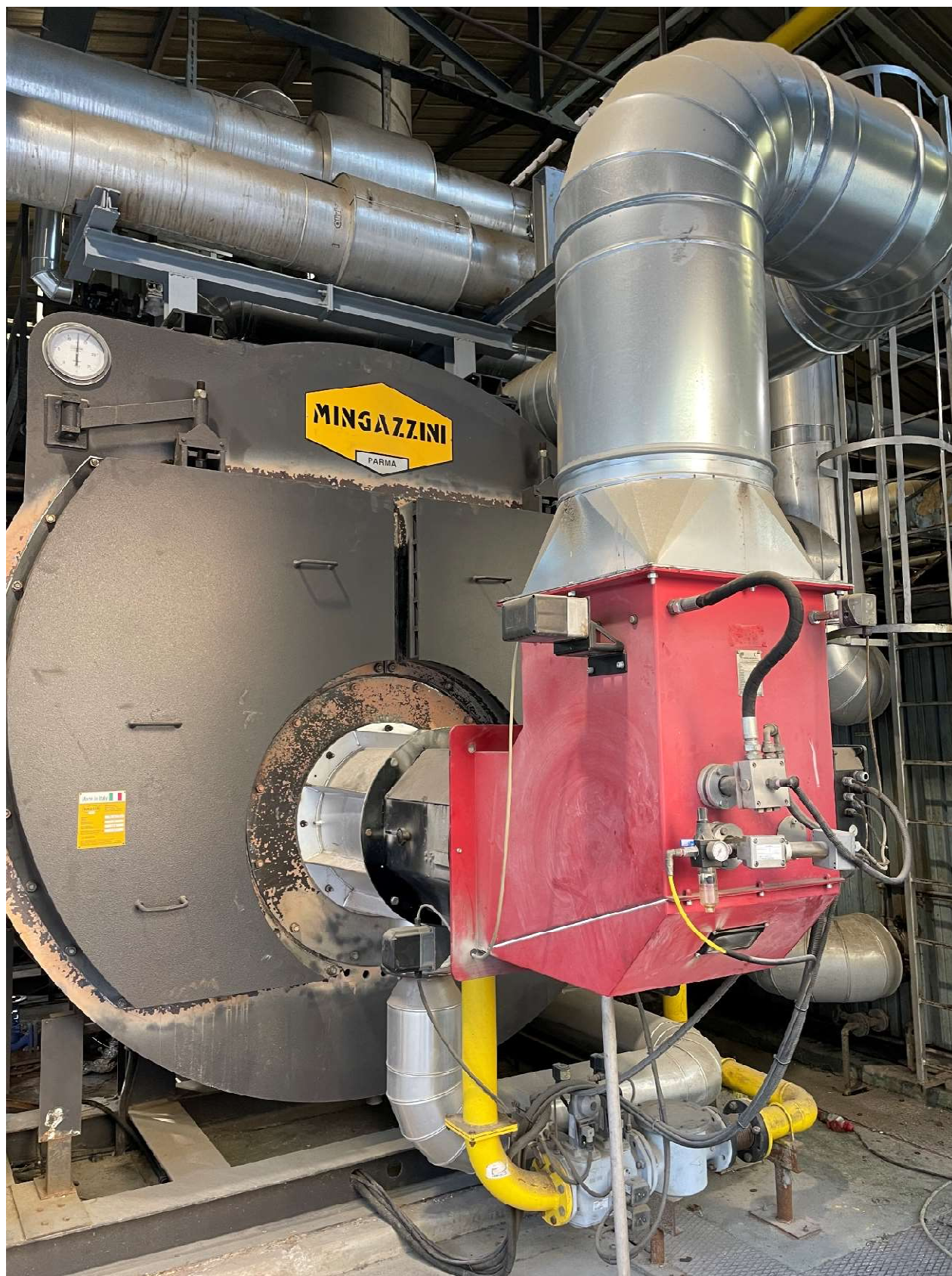
Figura 4 – Generatore di vapore Mingazzini interessato dalla sostituzione del bruciatore
