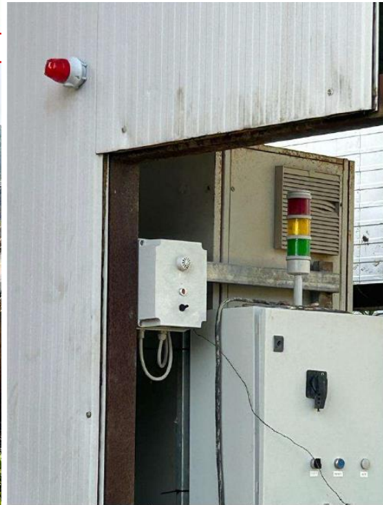
quadro di controllo ed allarme minimo acqua (segnalatori visivo ed acustico)
