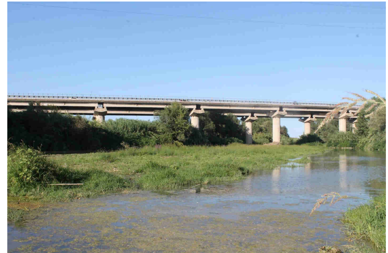
Figura 74: vista del viadotto da ovest
