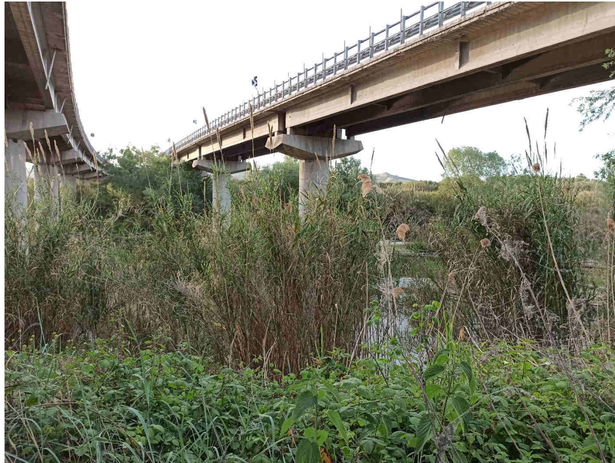
Figura 80: ambiente spondale allo stato attuale sotto il sedime autostradale
