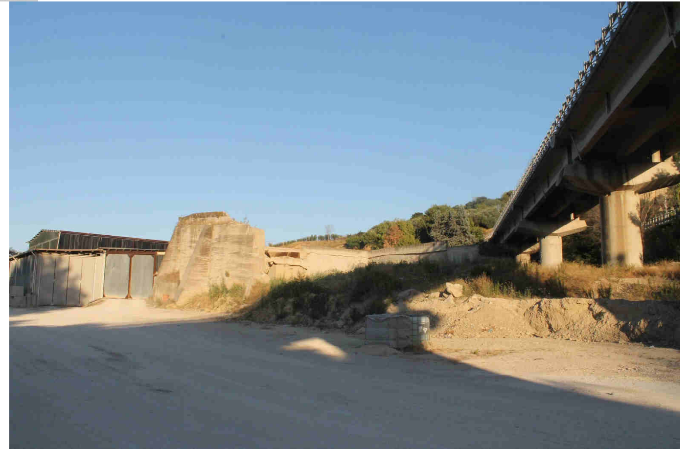
Figura 82: vista panoramica presso il deposito di inerti che insiste presso il viadotto
