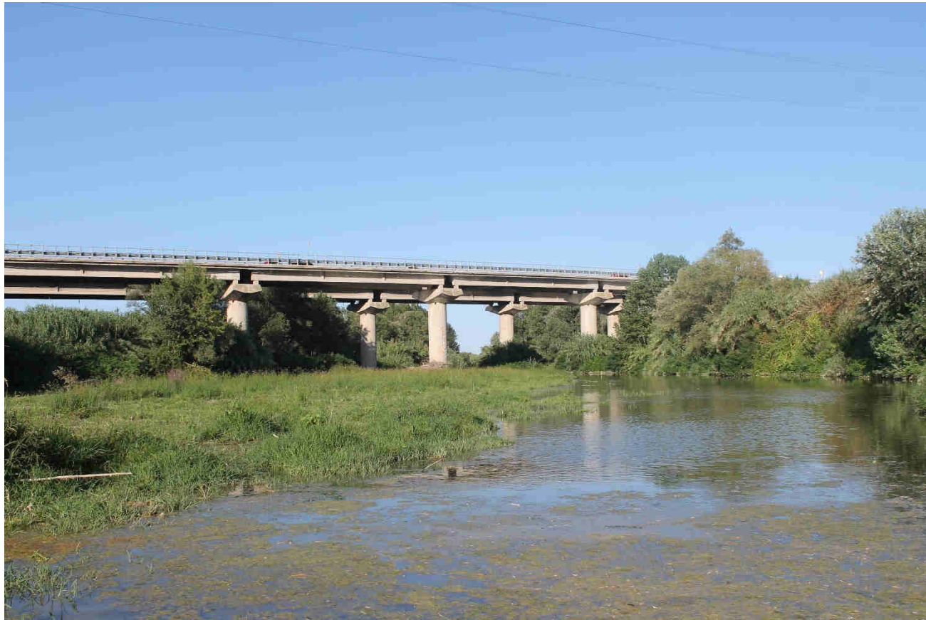
Figura 76: vegetazione in sponda destra (Regione Abruzzo) a monte del viadotto
