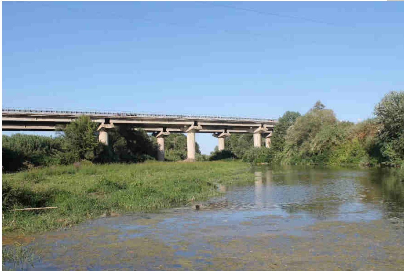
Figura 20: panoramica del tratto d'alveo che verrà interessato dal cantiere
