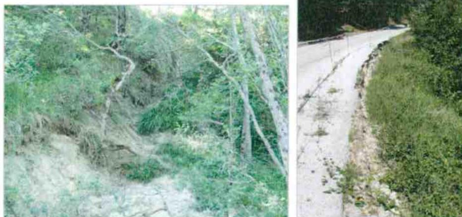
**Figura 34** - Area A1 Masseria Mincolavilla, scarpate con tendenza retrogressiva.
