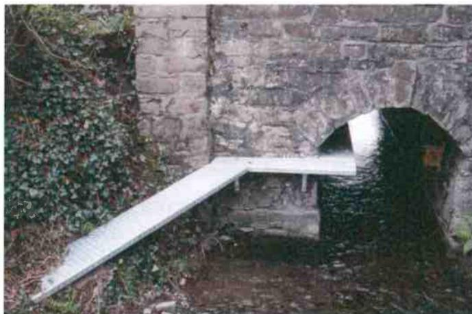
**Foto 10 Passerella in acciaio striato ancorata alla struttura del manufatto idraulico.**
