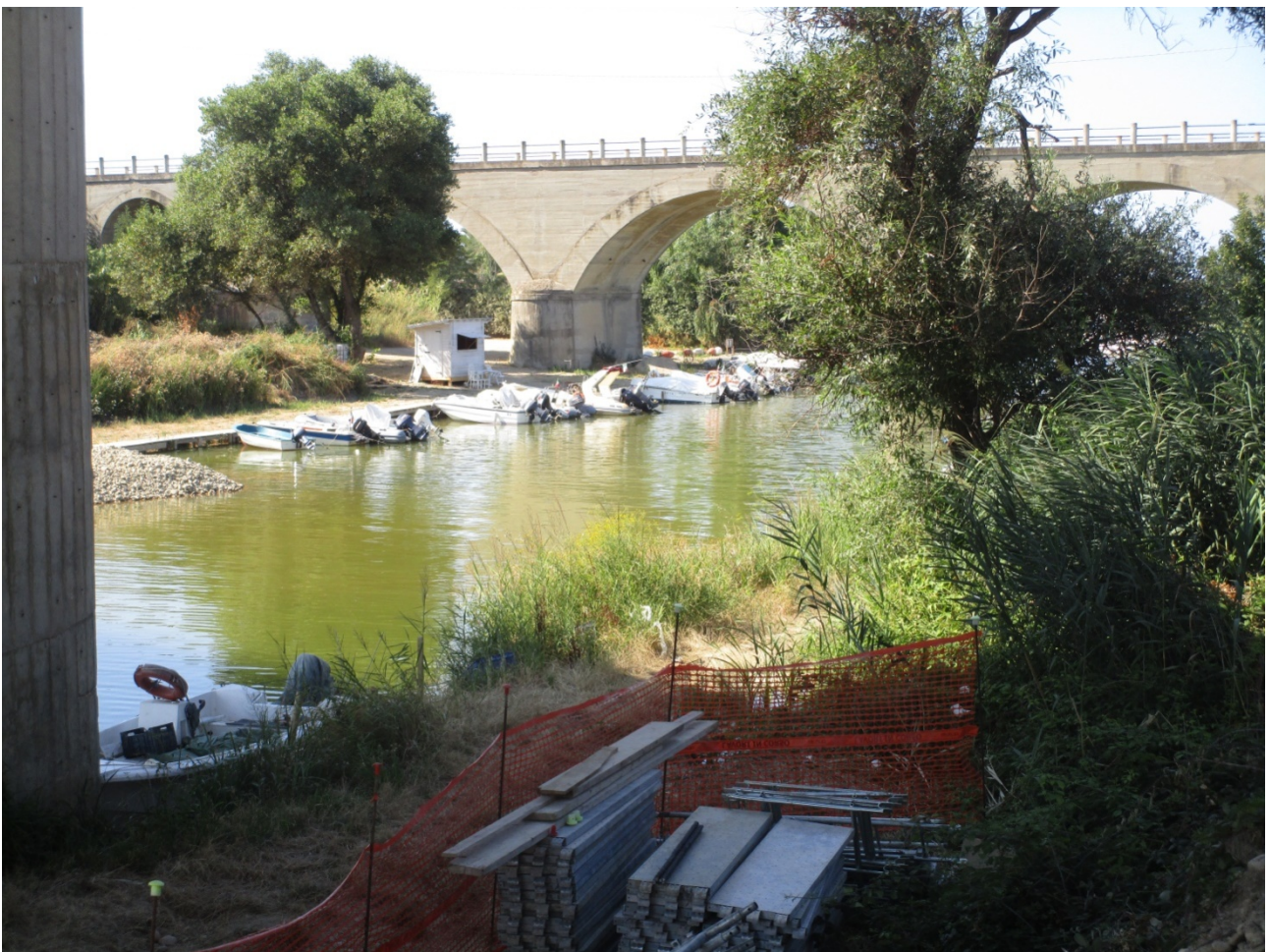
Figura 48. Foce del Sinello. I materiali edili testimoniano l'esecuzione di lavori di manutenzione al di sotto del ponte ferroviario.
