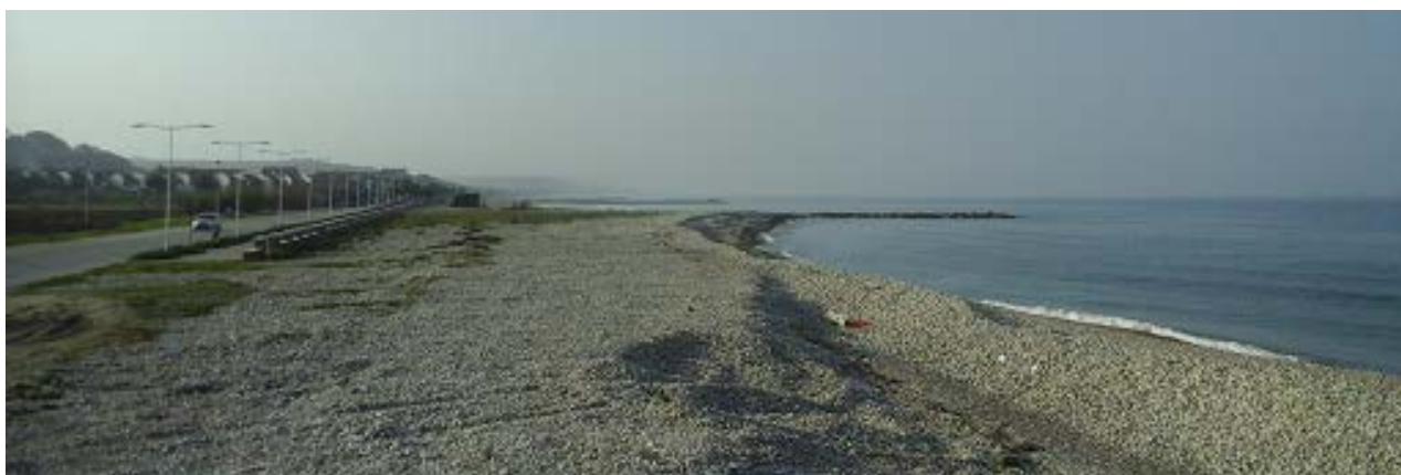
Figura 63. Litorale nord di Casalbordino. Sono visibili i caratteristici "pennelli" (ph: M.C. de Francesco).
