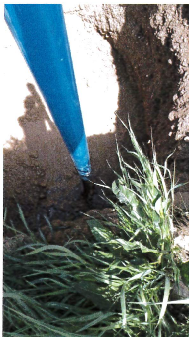
Foto 1, 2: alcune fasi di installazione dei piezometri S1 e S2
