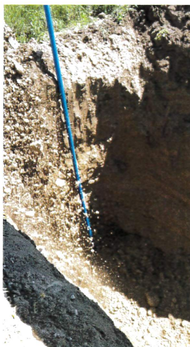
Foto 1, 2: alcune fasi di installazione dei piezometri S1 e S2
