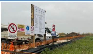
Area di cantiere - telo di protezione per anfibi e rettili
