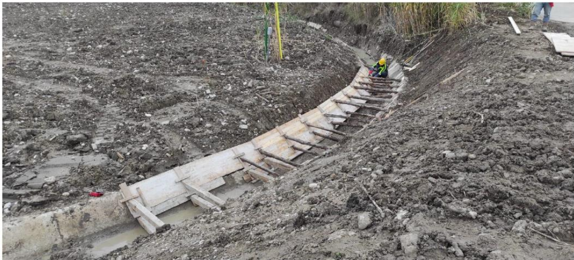
Fig. 1 – Ripristino canale irriguo
