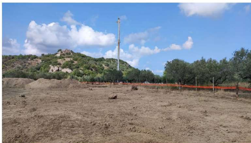
Fig. 3 – Fase di apertura pista delle aree di cantiere “Trigno”.
