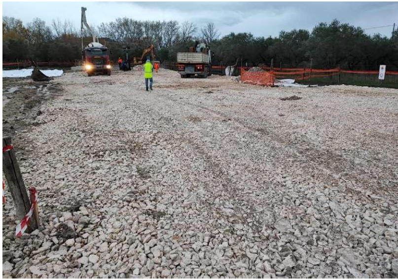
Fig. 4 – Fase di inghiaamento del piazzale ed allestimento area di cantiere “Trigno”.
