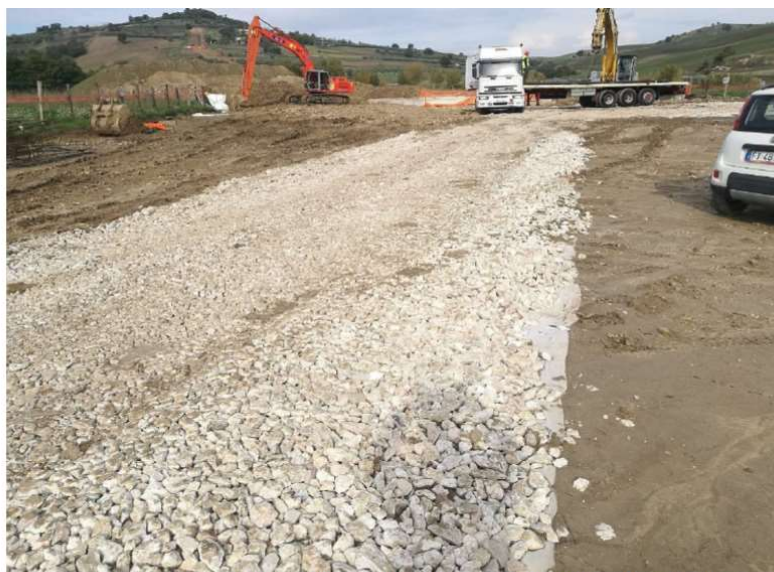
Fig. 2 – Fase di inghiaamento del piazzale ed allestimento area di cantiere “Treste” e “La Coccetta”.
