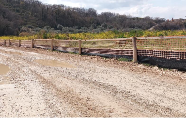
Strada di accesso - telo di protezione per anfibi e rettili
