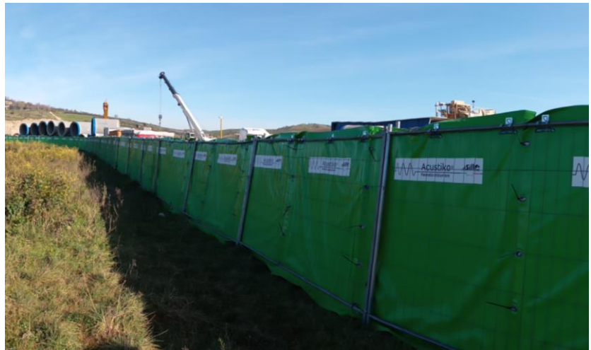
Barriera fonoassorbente da cantiere
