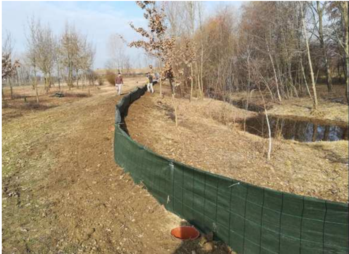
Figura 4: telo di protezione per anfibi e rettili (da catalogo Scubla)
