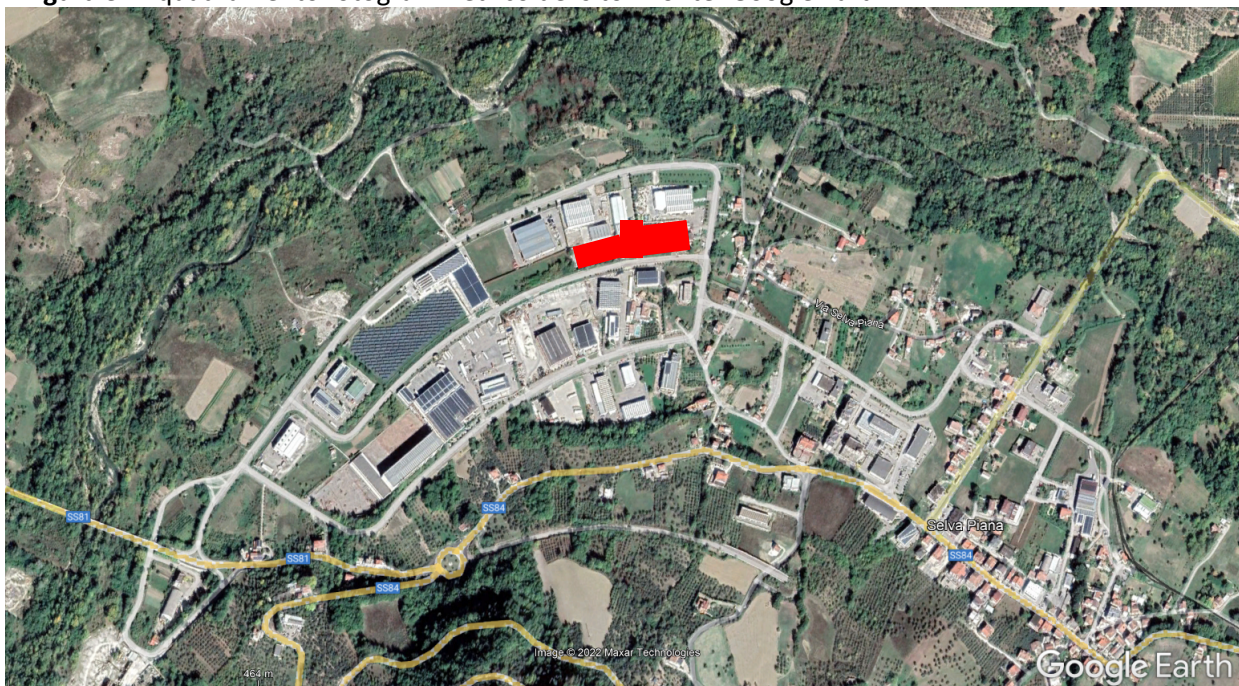
Figura 3: Inquadramento fotogrammetrico del sito - Fonte: Google Earth
