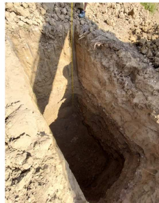
P3-Sondaggio 3: H scavo 6,70 - q.f. +37,10 - q.t. +44,70
