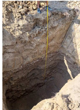
P3-Sondaggio 3: H scavo 6,70 - q.f. +37,10 - q.t. +44,70
