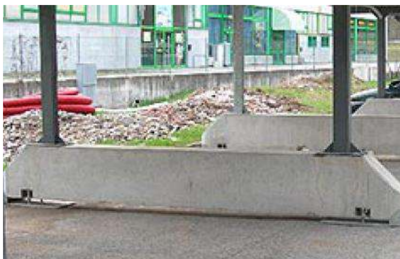
Figura 8.4.2.1: Esempio di basamento in cemento per tettoia.
