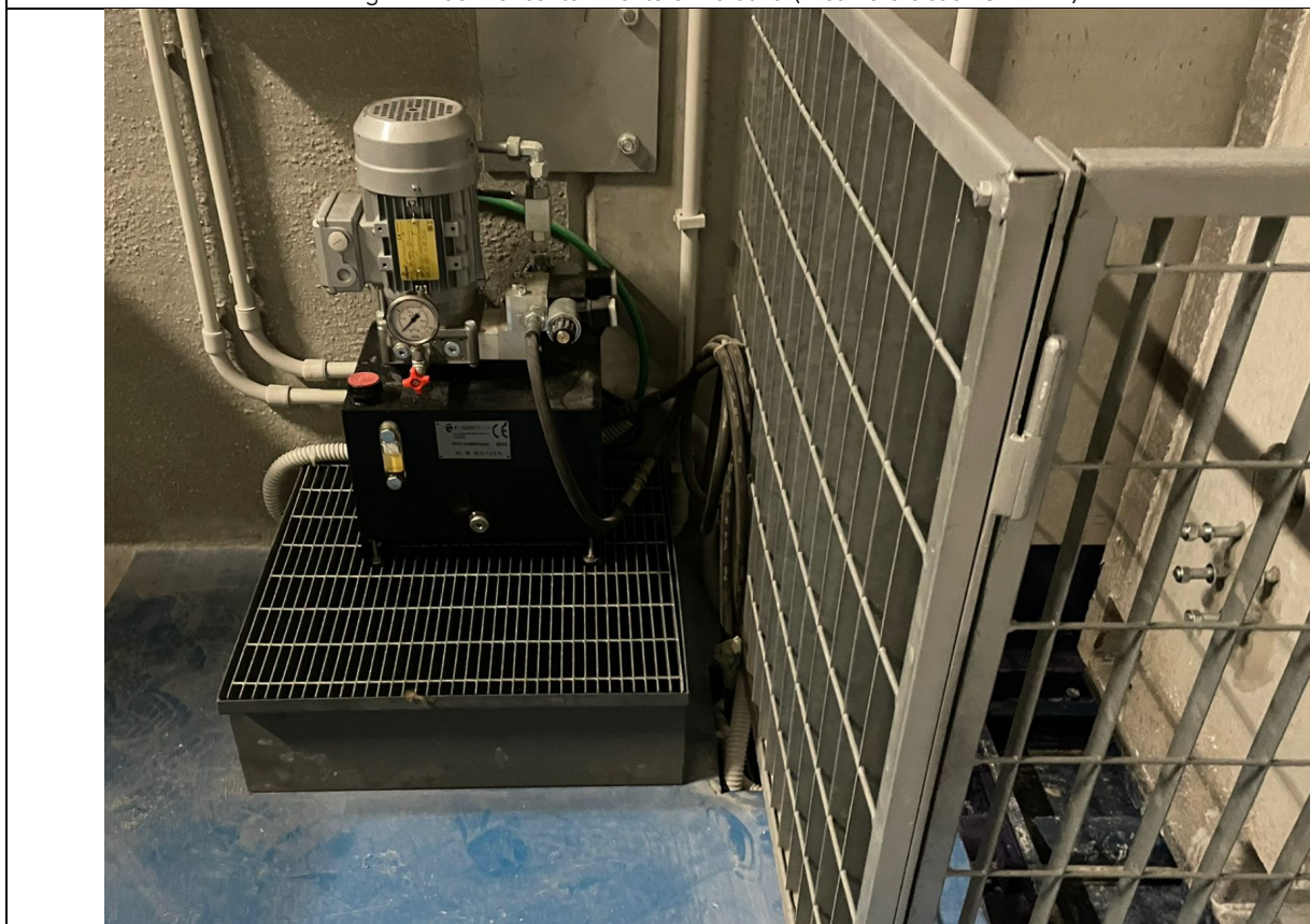
Fig. 2 – Bacini di contenimento olii idraulici (Particolare area nord LUNA MV)
