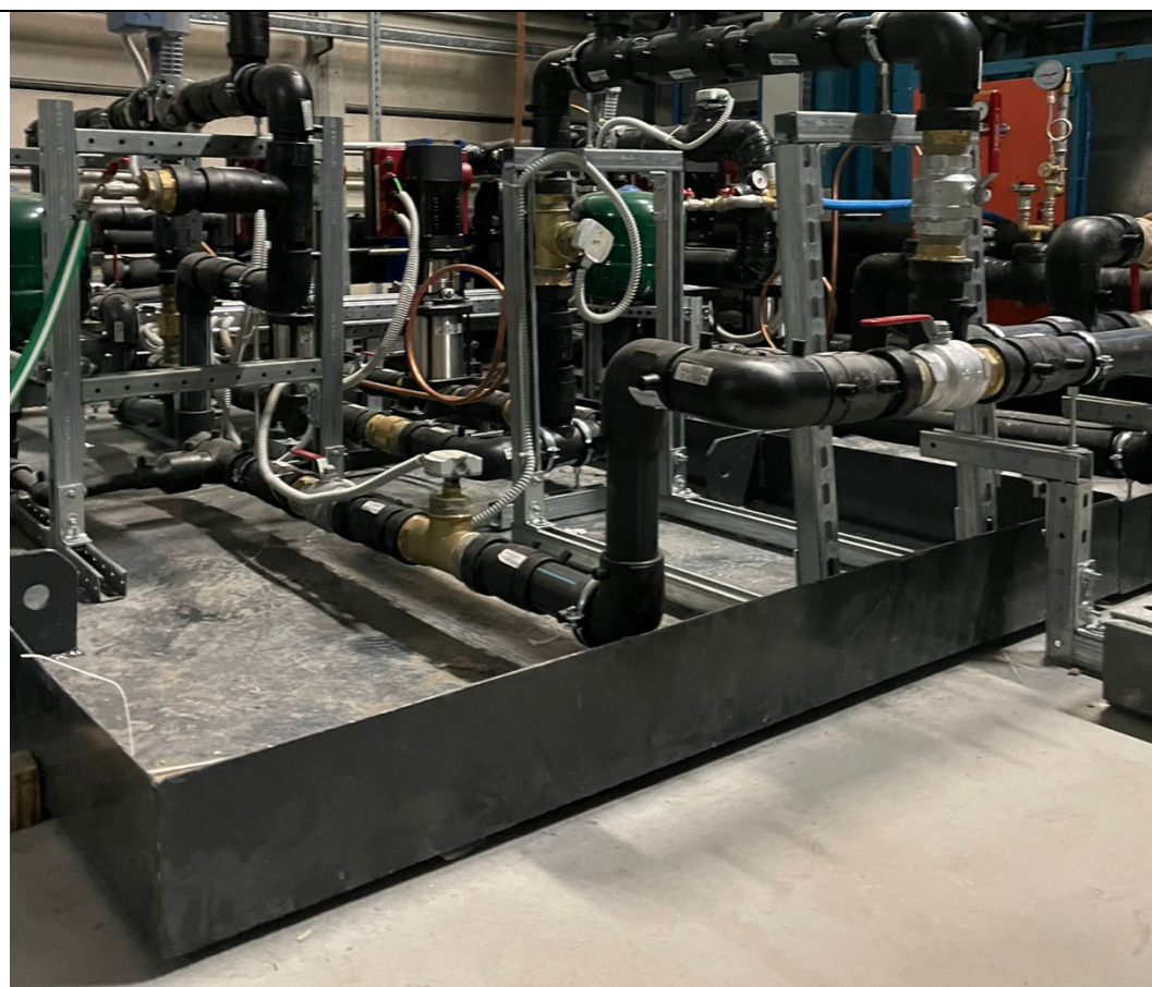
Fig. 4 – Bacini di contenimento impianto LUNA MV
