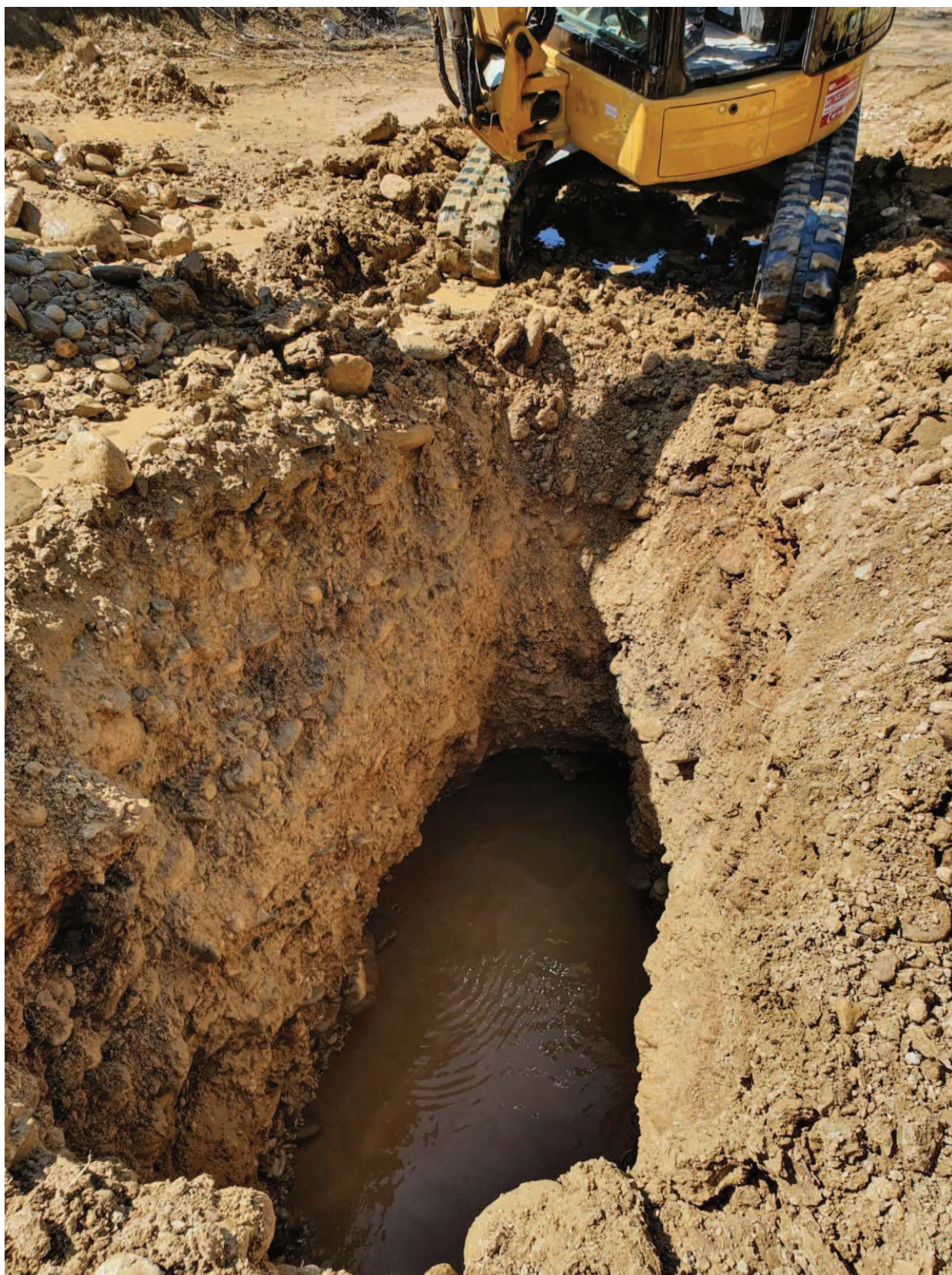
Scavo all'interno del deposito alluvionale; livello statico H 2 O 3,0m dal p.c.
