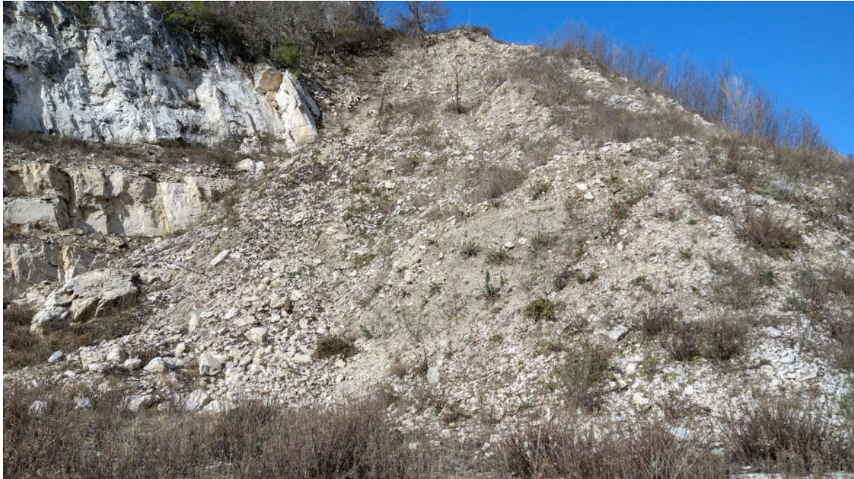
Figura 2: Particolare degli accumuli detritici presso il sito di intervento
