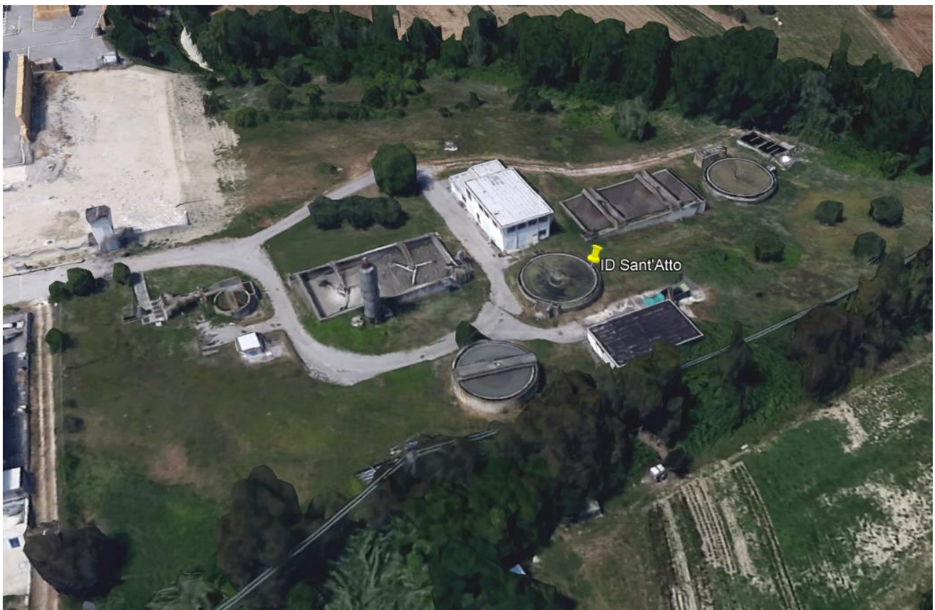
4-1 - Vista aerea dell'impianto di depurazione di S.Atto
