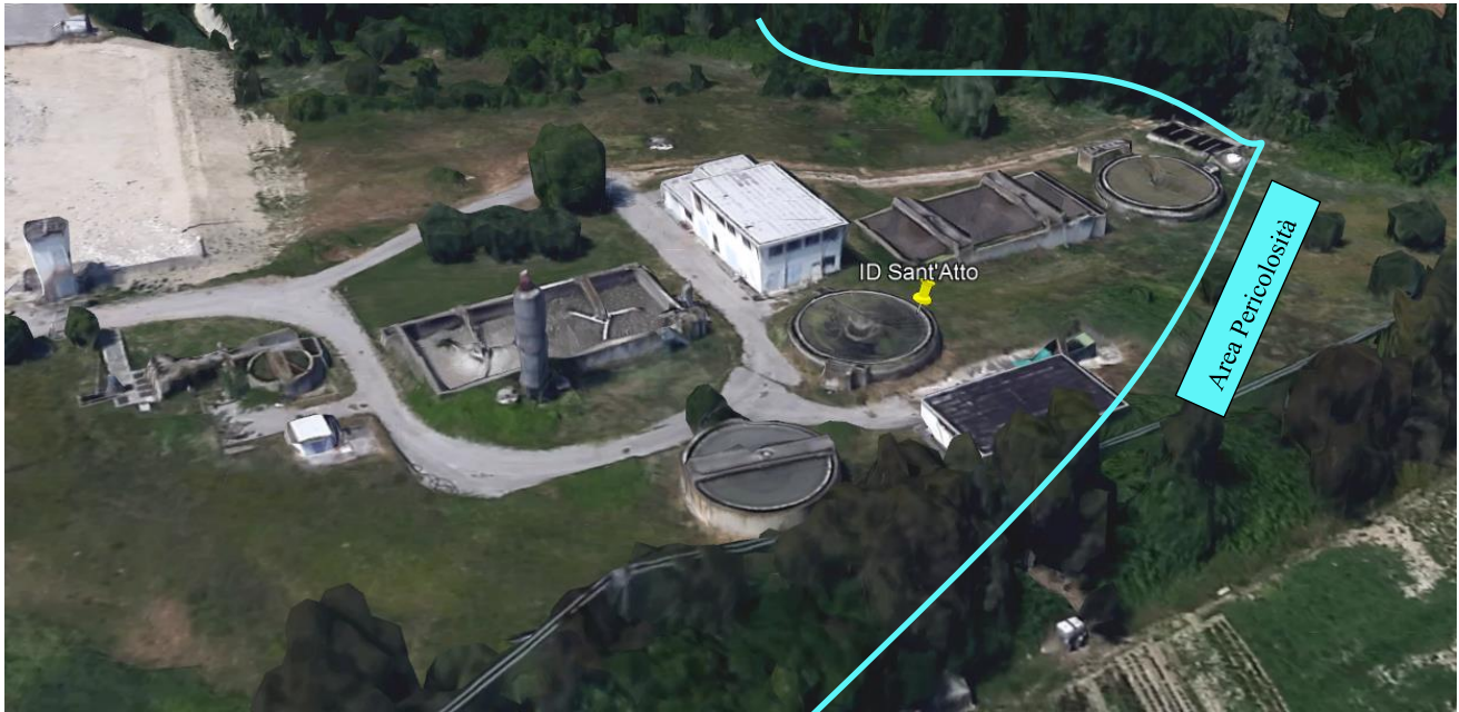
3-7 - Vista tridimensionale dell'area dell'impianto di depurazione e tracciamento dell'area a pericolosità idraulica esistente
