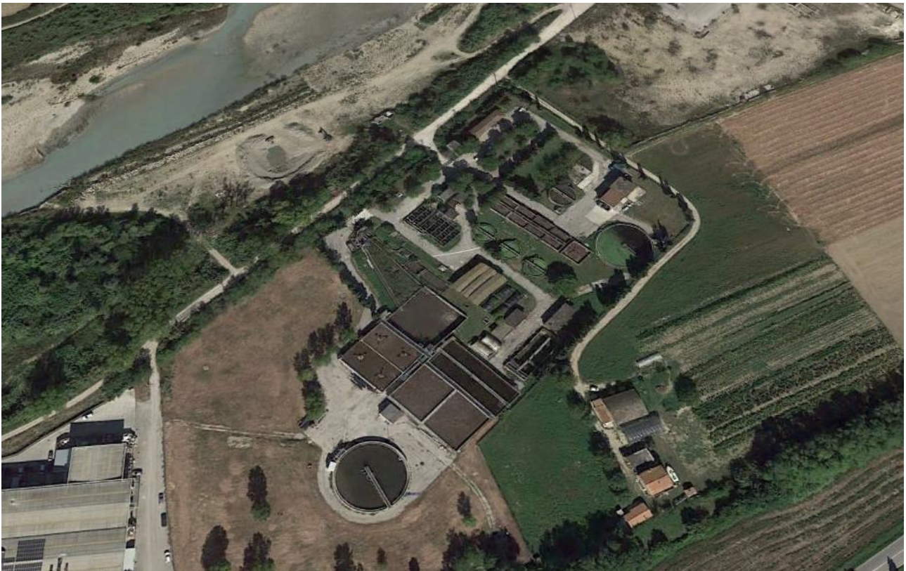
4-1 - Vista aerea dell'impianto di depurazione di Scerne
