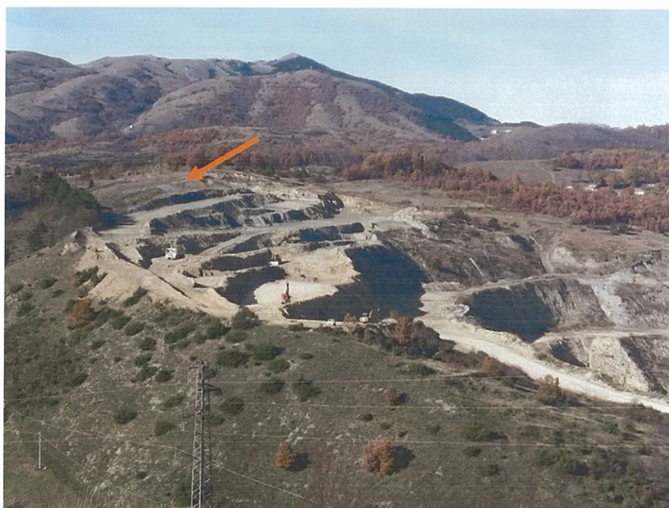
Foto 3 – Dettaglio del cantiere in lavorazione, si nota in alto a sinistra (indicato con la freccia arancione) l'accenno iniziale della riprofilatura di recupero ambientale pronta per il rinverdimento). Si evidenzia che i fronti di scavo debbono spingersi fino a lambire la vegetazione sullo sfondo (zona delle marne basse), secondo quanto indicato dal progetto di escavazione originario.
