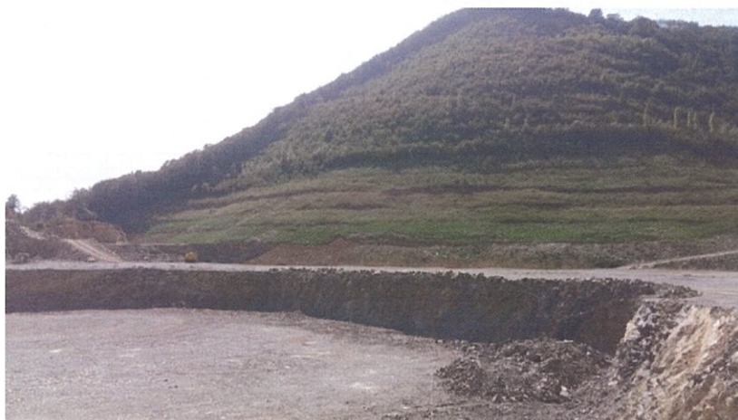
Foto 5 – Esempio di recupero ambientale a scarpata unica Miniera CementirSACCI di Cà Bianca nel comune di Parzanica (BG)
