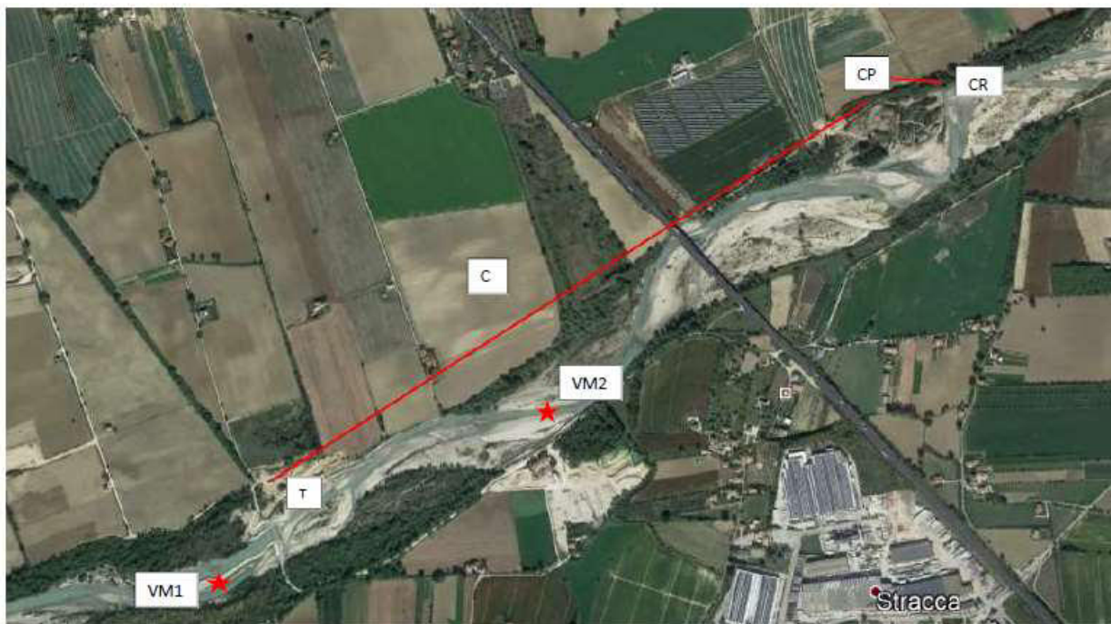
Foto 3 - Inquadramento dell'area di indagine lungo il fiume Vomano su foto aerea (immagini da Google Earth del 09/10/2019).
