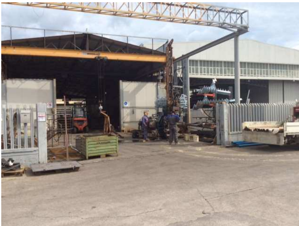
Fig.2 Trivellatrice idraulica CMV 420 sulla postazione del piezometro S1pz, ubicato a sud.
