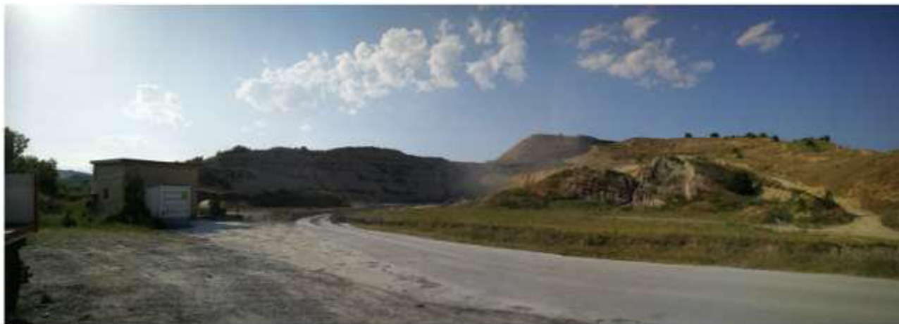
Zona sud di accesso ai cantieri di estrazione, si nota la strada asfaltata al fine di abbattere la polvere prima dell'uscita
