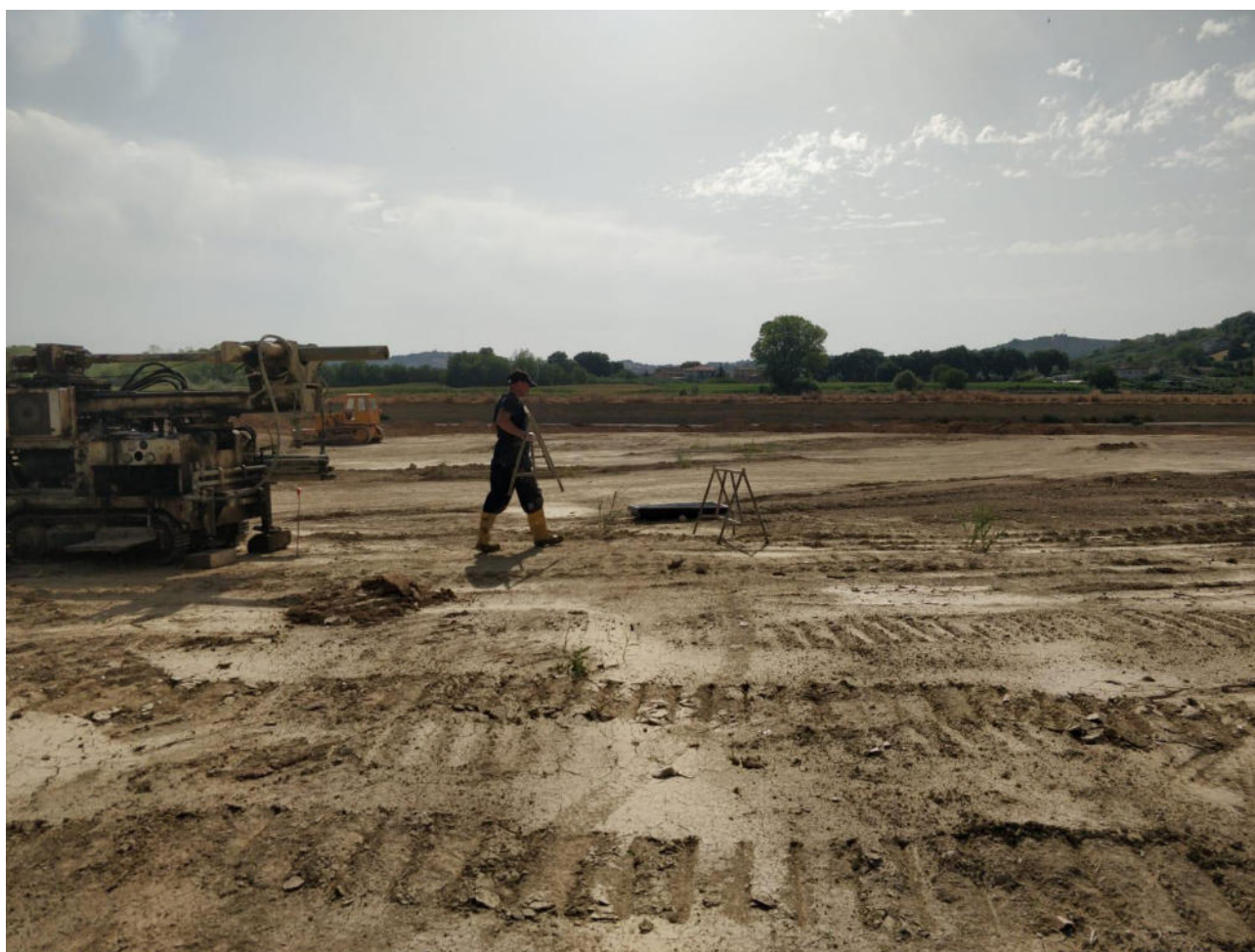
Figura 2 Operazioni di carotaggio effettuate dalla ditta Geognostica Srl
