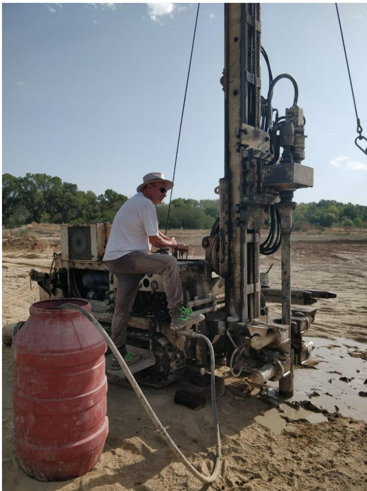
Figura 5 Operazioni di carotaggio effettuati dalla ditta Geognostica Srl
