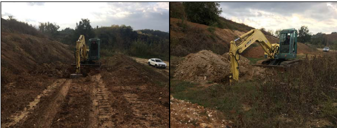
Figura 6.5: –Trincee esplorative TR2 e TR1 condotte all'interno dell'area di cava
