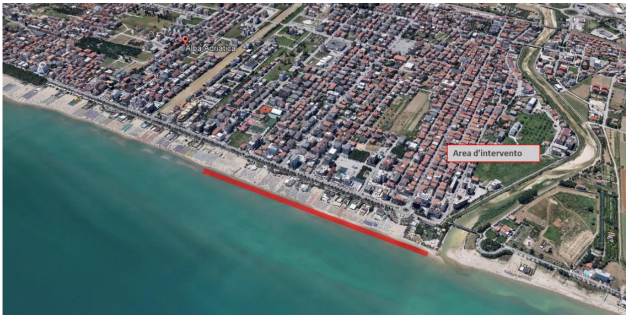
Figura 7.6 Vista aerea del contesto paesaggistico dell'area d'intervento
