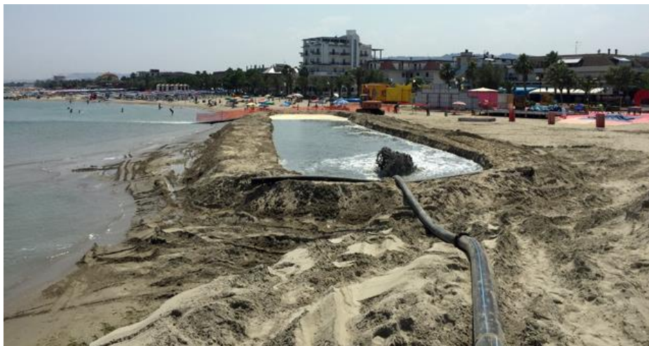
Figura 4.2 – Vasca di contenimento realizzata durante gli interventi di ripascimento effettuati dalla società Dragaggi Srl lungo un tratto di litorale del comune di Martinsicuro.
