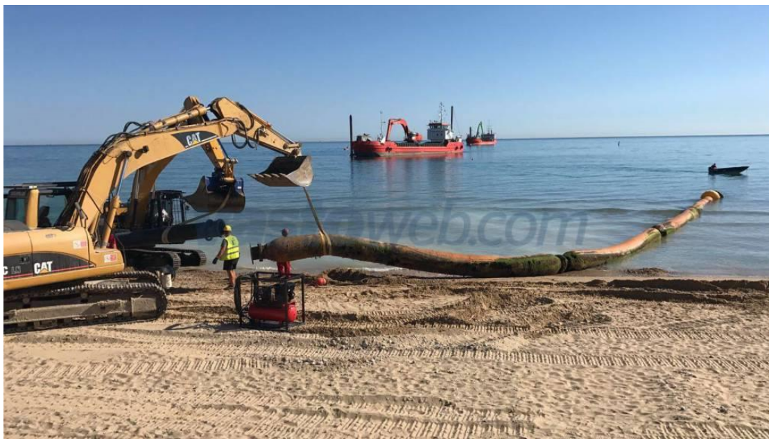
Figura 4.1 – Predisposizione della tubazione metallica per il refluimento della miscela sabbiosa dalla draga fino alla costa - Interventi di ripascimento nel Comune di Casalbordino.
