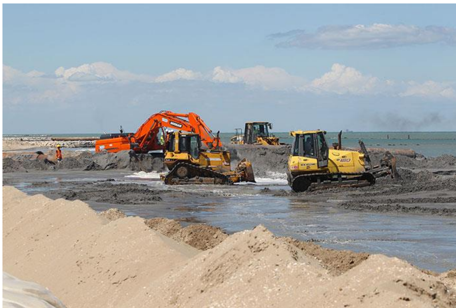
Figura 4.3 – Immagine rappresentativa delle lavorazioni in atto durante il refluimento e lo spandimento della miscela sabbiosa impiegata per il ripascimento del litorale.
