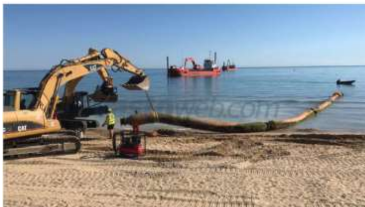
Figura 4.1 – Predisposizione della tubazione metallica per il refluentamento della miscela sabbiosa dalla draga fino alla costa - Interventi di ripascimento nel Comune di Casalbordino.
